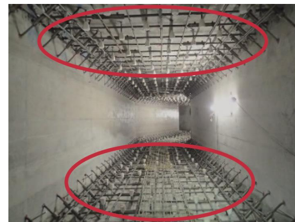
鉄筋により補強し、天井や床の厚みを増す耐震工事の状況（施工中）
