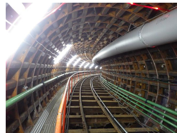
第二田柄川幹線（50ミリ施設整備）（整備中）
