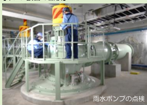
【雨水ポンプ設備の補修】
