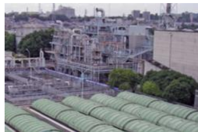
八王子市北野下水処理場 編入前（1969年稼働）
