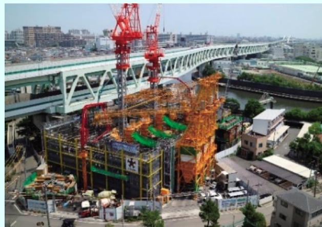
王子第二ポンプ所 (整備中)
