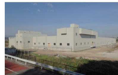
八王子水再生センターにおける 編入のための水処理施設増設
