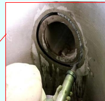
下水道管とマンホールの 接続部を対策する様子
