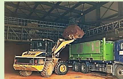
焼却灰の積込・搬出作業
