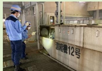
濃縮機の点検
