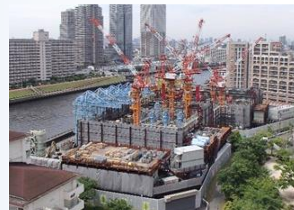
千住関屋ポンプ所 建設工事全景
