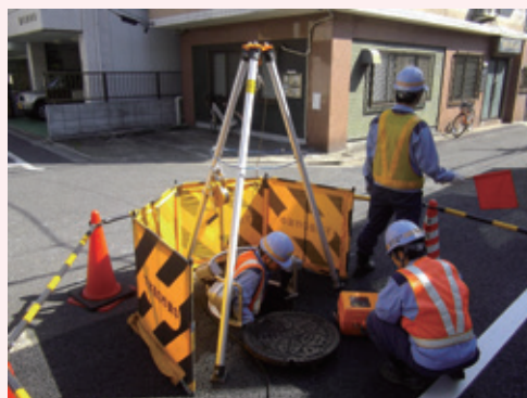
▲下水道管の点検
