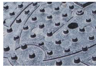
スリップ防止の突起が全面に施されている
