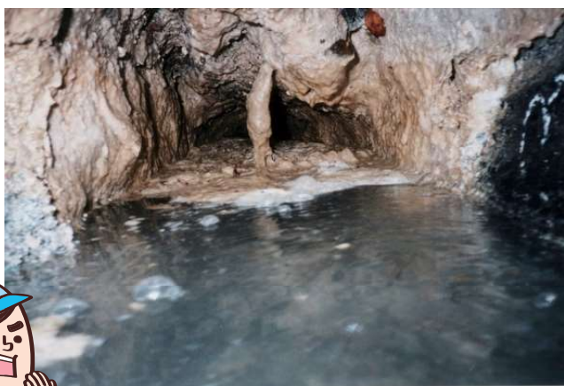
冷えて固まった油が付着した下水道管内
