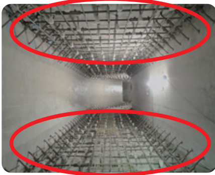
◀天井や床の厚みを増し補強する耐震工事の状況(施工中)
