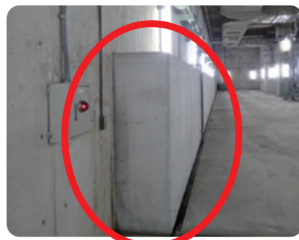
◀壁の厚みを増して耐震補強が完了した状況
