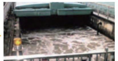
第一沈殿池からの下水に微生物の集まりを混ぜ合わせ、空気の泡を吹き込み6～8時間ほど攪拌します。このとき微生物が下水中の汚れを食べ、増殖することで下水はきれいになっていきます。
