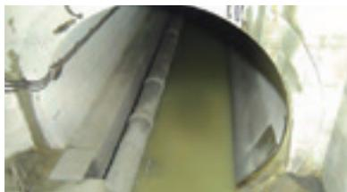
汚れた水や雨水を集めて、水再生センターまで運びます。水が自然に流れるよう、ななめに少しずつ地下深く下がっていくように作られています。
