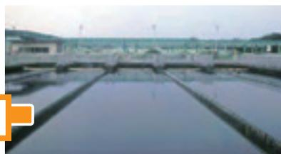
反応槽で増殖した微生物などの汚泥塊を約3～4時間かけて沈殿させ、上澄みの水と分離させます。
