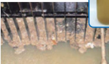
水再生センターで下水が最初に入る池です。大きなゴミを取り除き、土砂等を沈殿させます。
