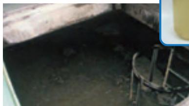
沈砂池で取り除けなかった小さなゴミや土砂を沈殿させるため、約2～3時間かけて下水をゆっくり流します。
