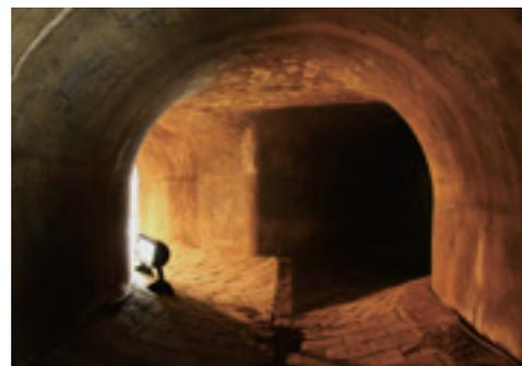
東西に分かれて沈砂池を通った下水が合流する「唧筒井接続暗渠」
