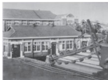
当時の「沈砂池」。下水を池の中でゆっくり流し、下水中の土砂を沈殿させて取り除きます。右手前は、沈殿した土砂を回収する「かき揚機」
