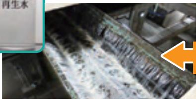
処理水の一部は砂の層でろ過するなどして、更にきれいにしてトイレ洗浄水などとして供給します。
