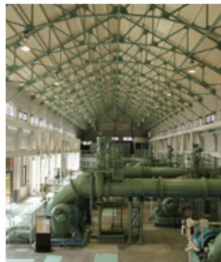
「唧筒室」内観。下水を地下のポンプ井から吸い上げるポンプが10台設置されています
