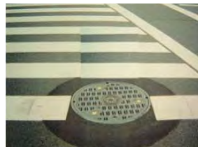
浮上・飛散防止型マンホール蓋への取換え状況
