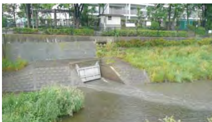
雨水吐口からの流出状況
