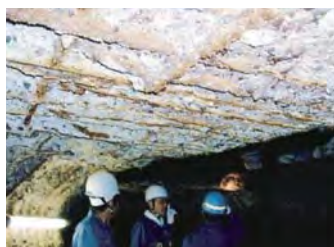
再構築前の下水道管
