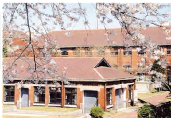
旧三河島汚水処分場唧筒（ポンプ）場施設（平成19年 重要文化財指定）
