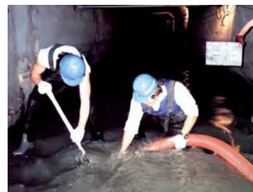
人力による下水道管内の清掃
