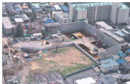
野川処理区下流部雨水貯留池施工状況(平成25年度完成予定)
