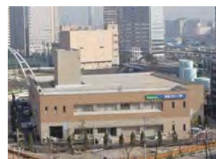
ポンプ所の建設
