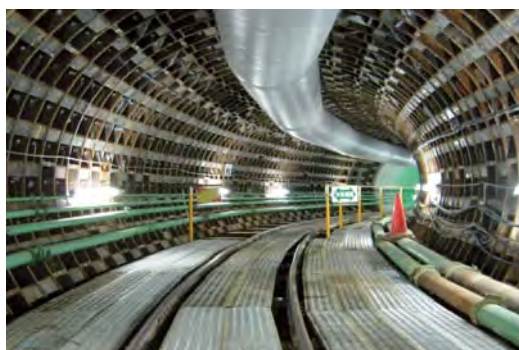
雨水幹線の整備
