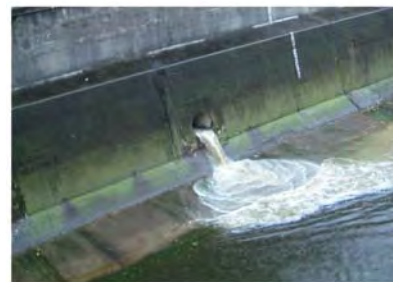
雨水吐口からの放流の状況
