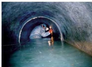
人力による下水道管内の調査
