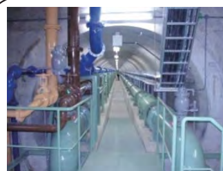
連絡管の内部
