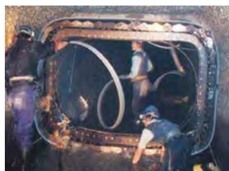
再構築中の下水道管
