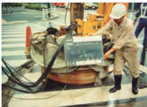
浮上・飛散防止型マンホール蓋への取換え状況
