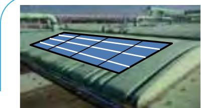
水処理施設の臭気対策用の蓋の再構築にあわせ、蓋に太陽光発電パネルを張り付けることで、コストを縮減
