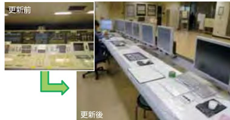
老朽化した大型監視制御盤を省電力型モニターに更新
