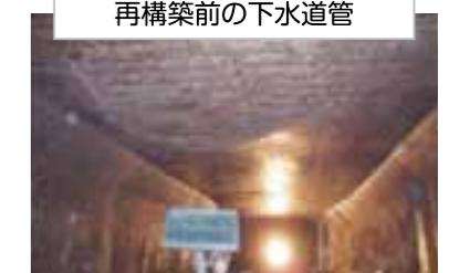
コンクリート表面の劣化や鉄筋の腐食などにより、下水道管の強度が低下します。
