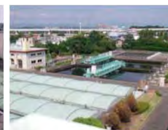
立川市・錦町下水処理場
