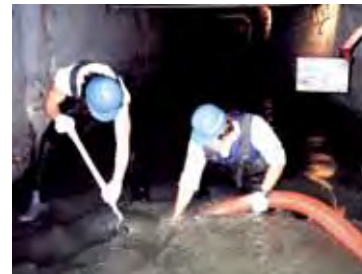
人力による下水道管内の清掃
