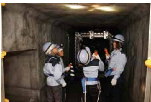
東京都虹の下水道館お仕事体験（下水道管）
