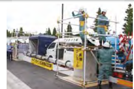
ライフライン応急復旧訓練
