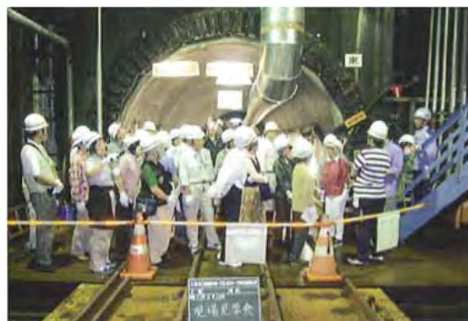
工事現場見学会
