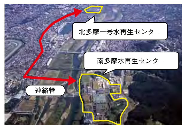
北多摩一号・南多摩水再生センター間連絡管 (平成25年度稼働)
