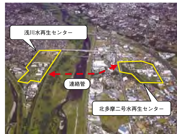
北多摩二号・浅川水再生センター間連絡管 (建設中)
