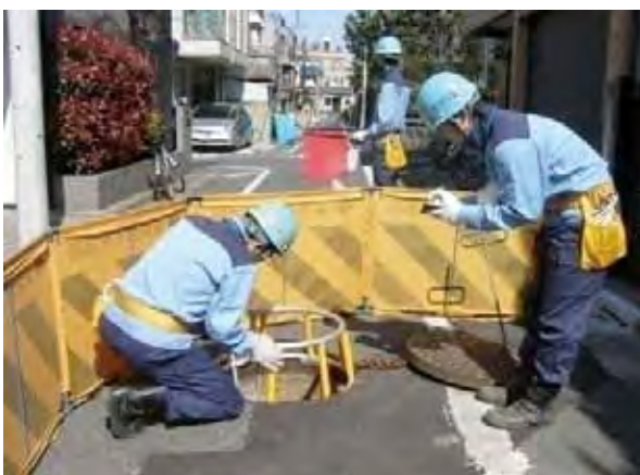
TGS社員による下水道管の点検作業の様子
