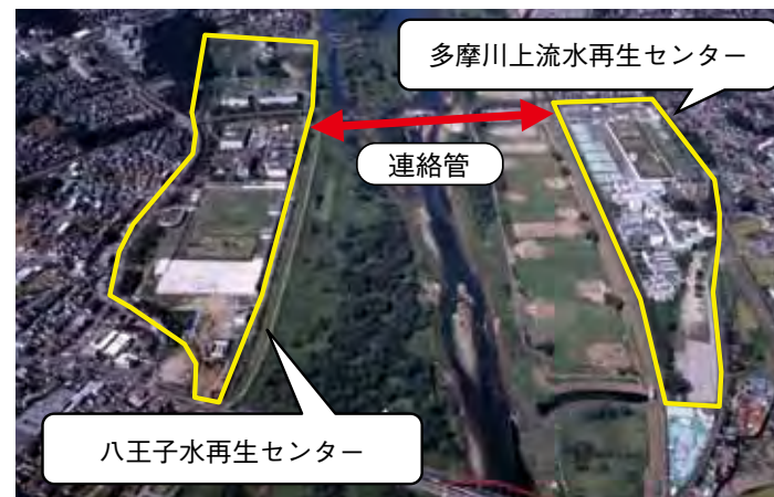
多摩川上流・八王子水再生センター間連絡管 (平成18年度稼働)
