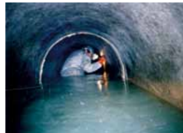
人力による下水道管内の調査
