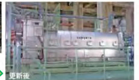
更新に合わせて省エネルギー型の脱水機を導入 （清瀬水再生センター）
