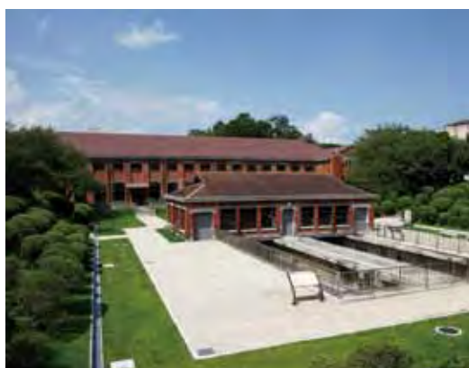
旧三河島污水処分場唧筒（ポンプ）場
