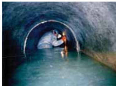
人力による下水道管内の調査
