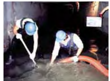
人力による下水道管内の清掃
