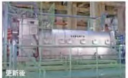
更新に合わせて省エネルギー型の脱水機を導入 (清瀬水再生センター)
