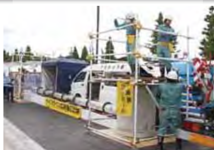
ライフライン応急復旧訓練
