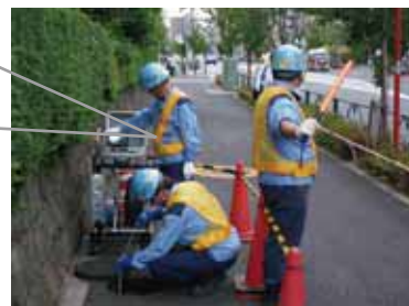
簡易なテレビカメラによる取り付け管の調査
