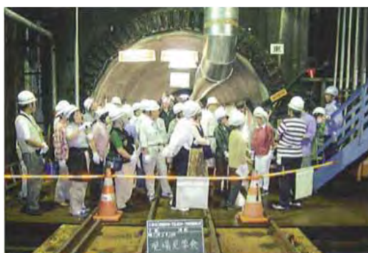
工事現場見学会
