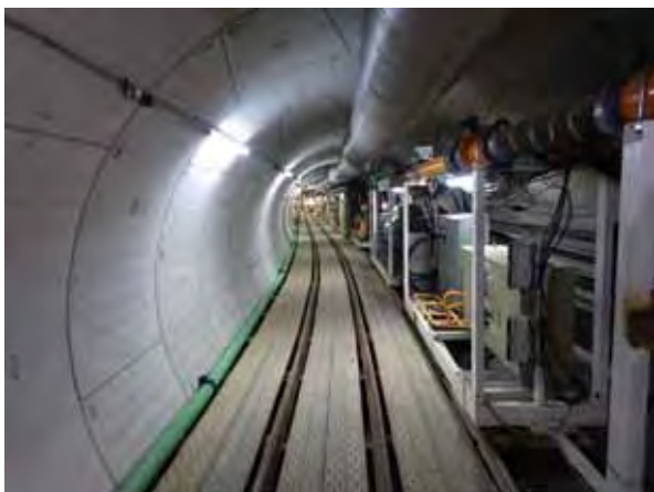
建設中の連絡管
