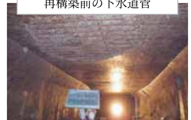
再構築前の下水道管
