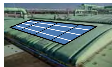
水処理施設の臭気対策用の蓋の再構築にあわせ、蓋に太陽光発電パネルを貼り付ける
