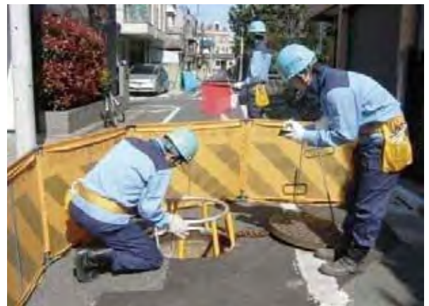
TGS社員による下水道管の点検作業の様子
