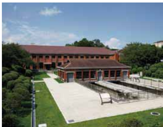
旧三河島污水処分場唧筒（ポンプ）場
