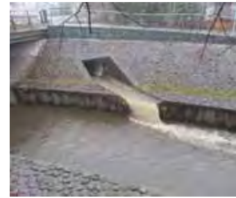
大雨時の雨水吐口からの越流状況
