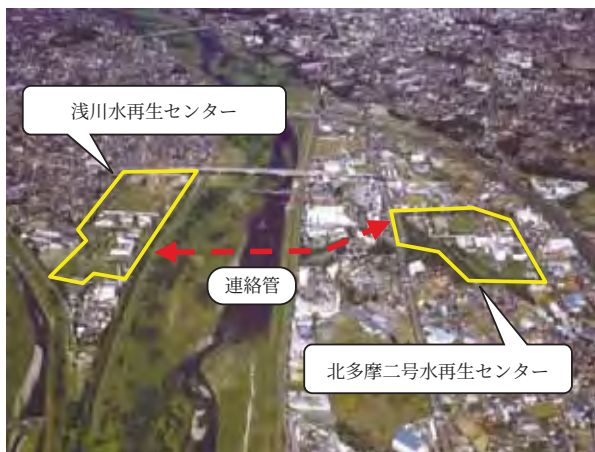
北多摩二号・浅川水再生センター間連絡管 (建設中)
