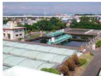
立川市・錦町下水処理場
