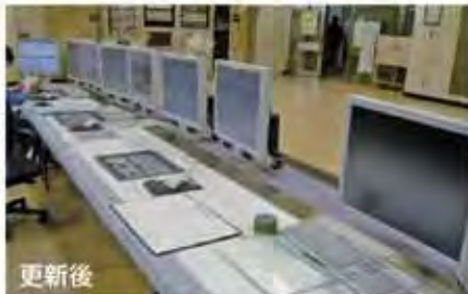
老朽化した大型監視制御盤を省電力型モニターに更新 (北多摩二号水再生センター)
