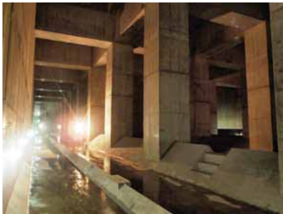
野川下流部雨水貯留池(平成26年度稼働)
