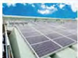
水処理施設の臭気対策用の蓋の再構築にあわせ、蓋に太陽光発電パネルを貼り付ける
