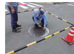
人孔蓋の点検
