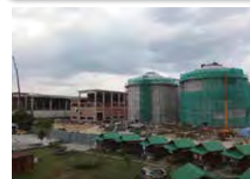
マレーシア・ランガット地区の下水処理場建設現場
