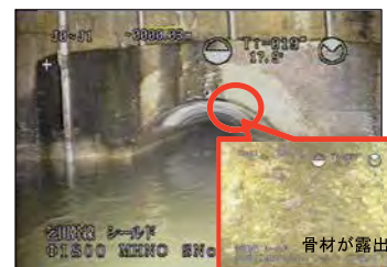
管内水位が高く老朽化が進んでいる幹線 (マンホール内から撮影した乞田幹線)
