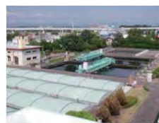
立川市・錦町下水処理場
