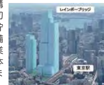
ポンプ所用地も活用した常盤橋地区の再開発（出典：三菱地所株）
