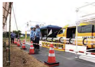
ライフライン応急復旧訓練
