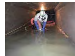
人力による下水道管内の清掃
