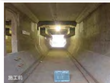
施設の耐震化実施例(コンクリートによる増打ち) (南多摩水再生センター)
