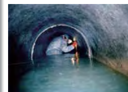
人力による下水道管内の調査
