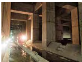
野川下流部雨水貯留池（平成25年度完成）
