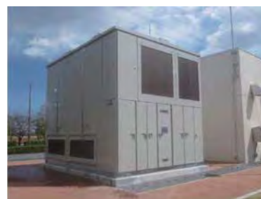
施設の耐震化実施例(コンクリートによる増打ち) (南多摩水再生センター)
