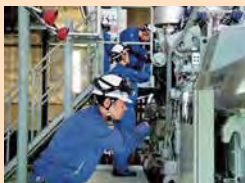
TGS社員による下水道施設の点検
