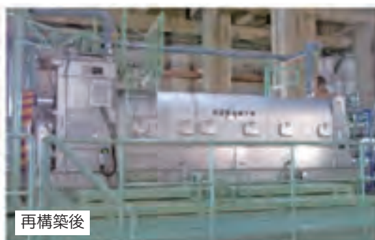
省エネルギー型の脱水機に再構築 (清瀬水再生センター)
