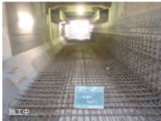
施設の耐震化実施例(コンクリートによる増打ち) (南多摩水再生センター)
