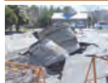
マンホールの浮上被害事例 (東日本大震災・平成23年、浦安市)
