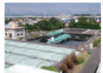
立川市・錦町下水処理場
