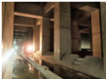
野川下流部雨水貯留池(平成25年度完成)
