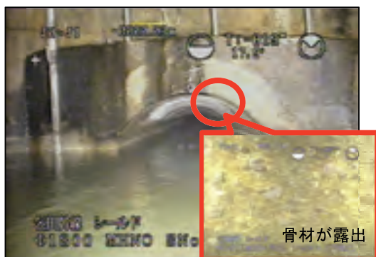
管内水位が高く老朽化が進んでいる幹線 (マンホール内から撮影した乞田幹線)
