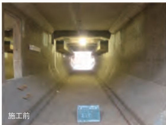
施設の耐震化実施例(コンクリートによる増打ち) (南多摩水再生センター)
