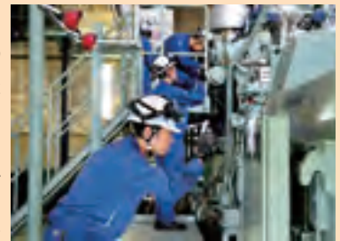
TGS社員による下水道施設の点検
