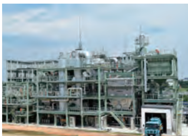
南多摩水再生センター汚泥ガス化炉
