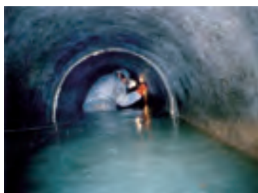
人力による下水道管内の調査
