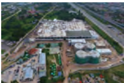
マレーシア・ランガット地区の下水処理場建設現場
