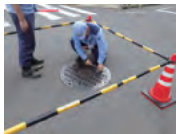
人孔蓋の点検
