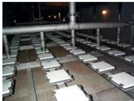
図-1 新しくなった散気設備
