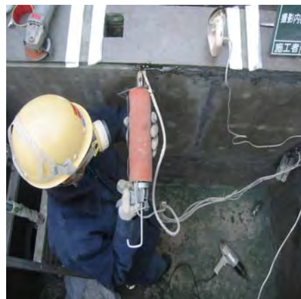
熔融硫黄填充装置
