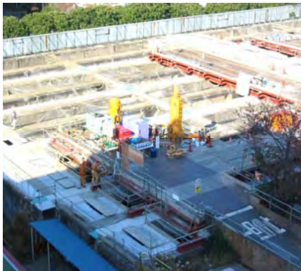
吹付けプラント（架台上）
