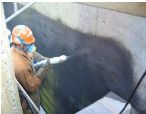
③吹付け施工
