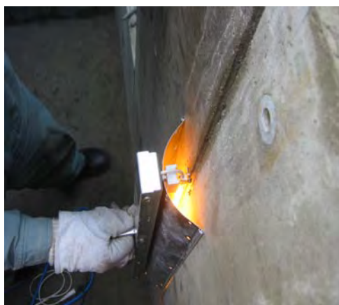
母材目地部熔融装置
