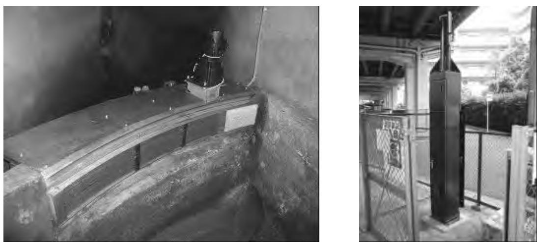
写真 3-1 円弧形スクリーン設置状況
