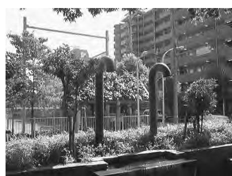
図-2 ステッキ型空気抜き施設
