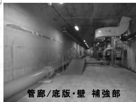
図-8 耐震補強箇所（B2F）
