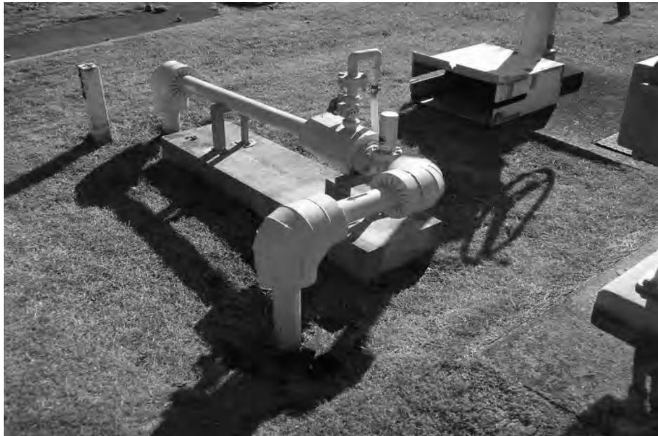
図-4 3系次亜塩素酸ナトリウム注入設備（注入点）
