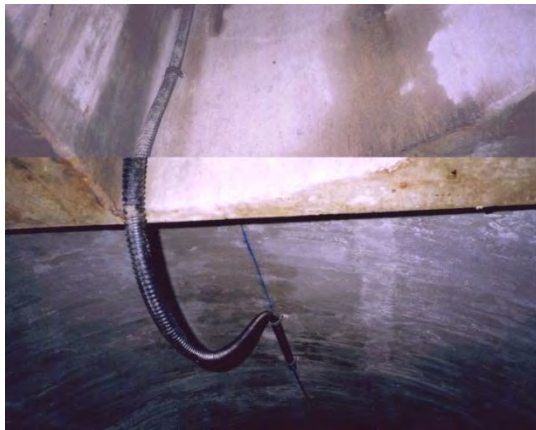
図4 人孔下部ケーブル敷設状況 (竣工当時)
