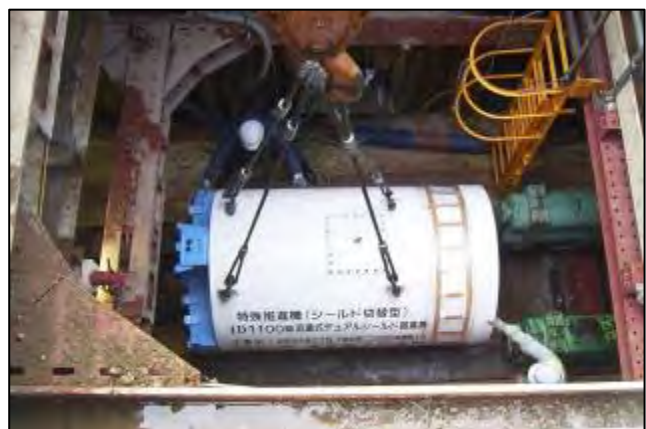
写真-1 デュアルシールド掘進機
