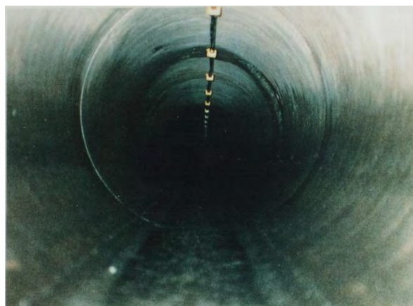
図 3 管きょ内に敷設された光ファイバー
