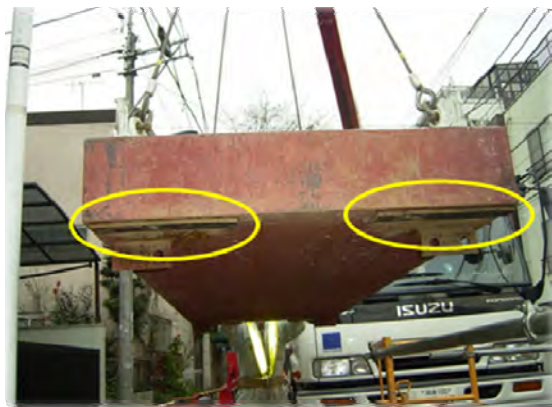
写真－4 防振ゴムの設置
