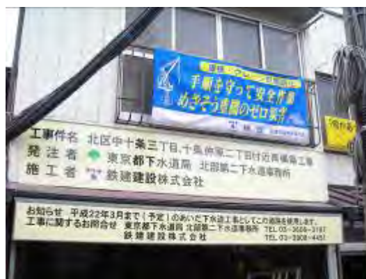
写真－6 民家を借用した作業詰所
