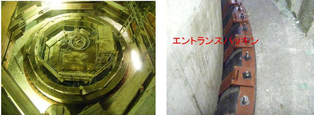
図 1 1 止水装置設置状況
