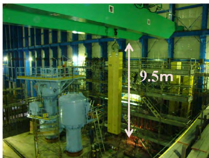
図9 防音ハウス内の天井クレーン
