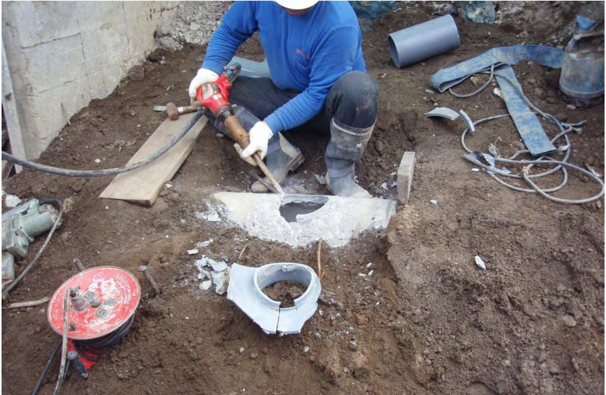
写真3 電動ドリルによる接着剤はつり状況
