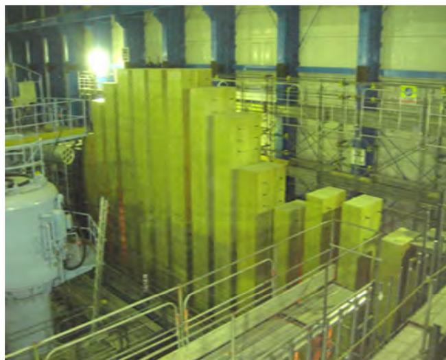
図13 S E W部材の分割施工状況
