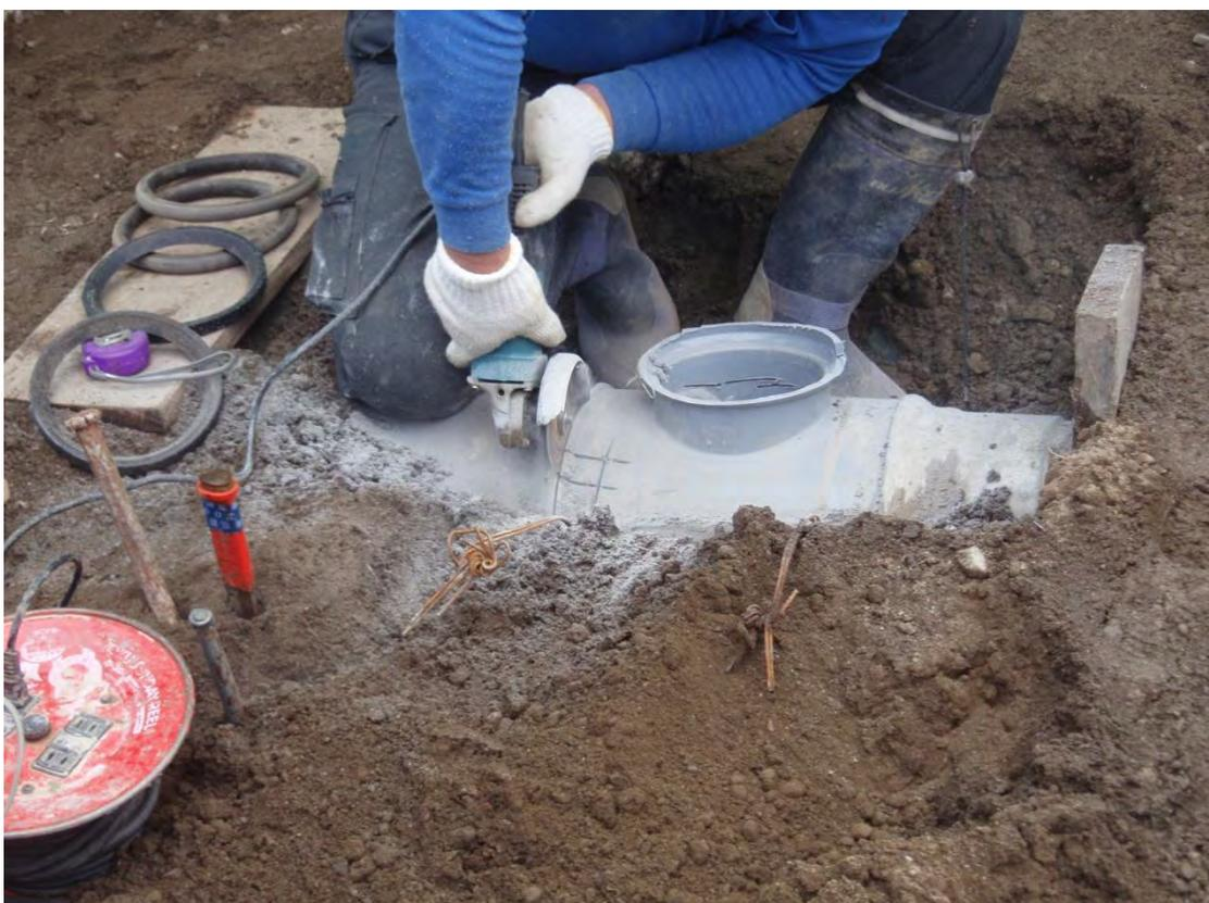
写真2 ベビーサンダーによる既設支管分割状況
