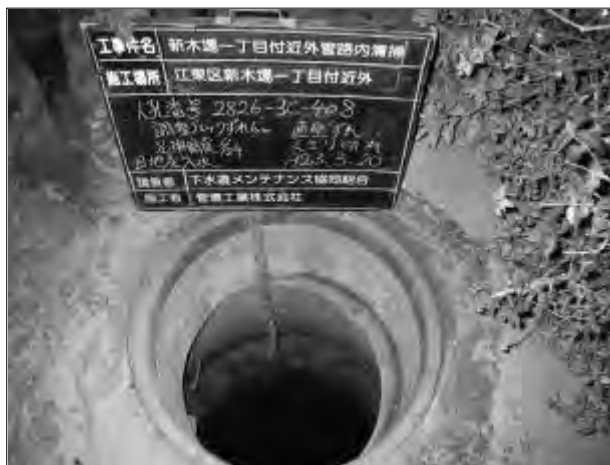
図-14 人孔側隕のずれ
