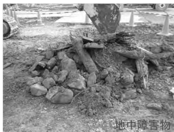
図 1 3. 目視確認（地中障害物）
