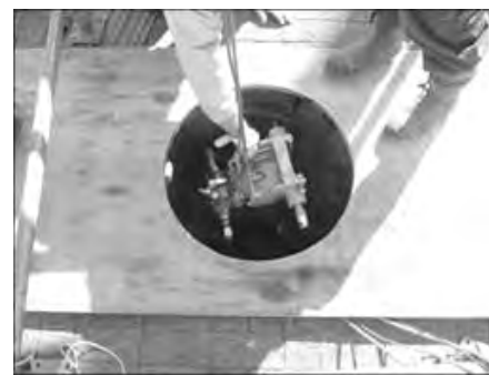
図 24 切削機の撤去
