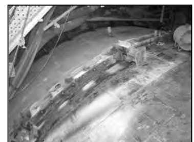
図－19 止水・固定状況
