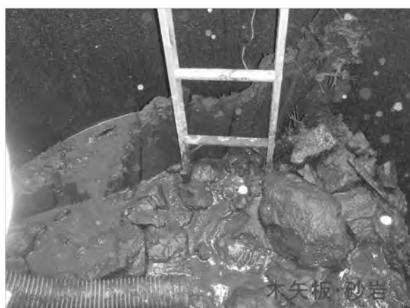
図 1 2. 目視確認（木矢板・砂岩）
