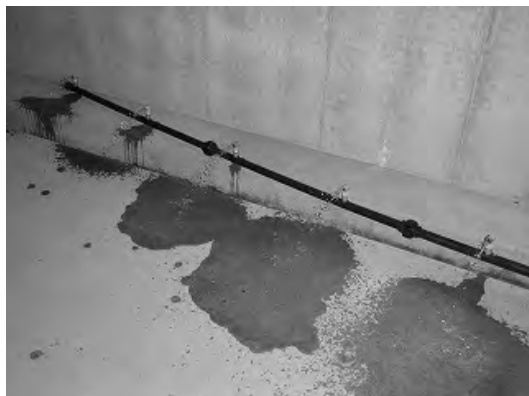
ノズルの点検（八王子水再生センター）
