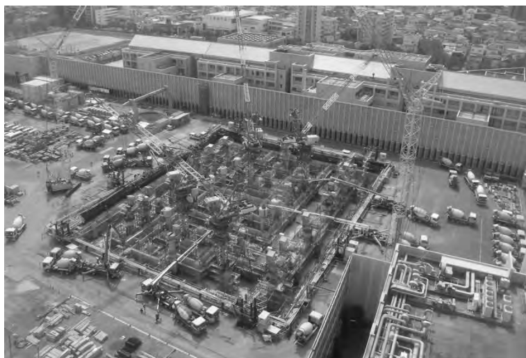
図-17 中埋めコンクリート打設状況(地上部)
