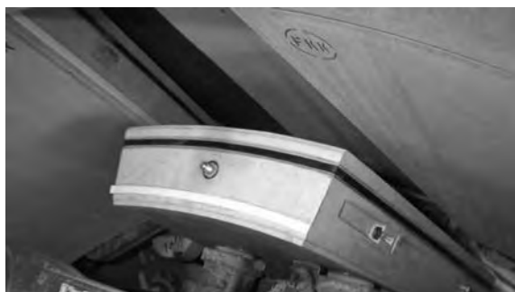
ボルトレスセグメント設置状況
