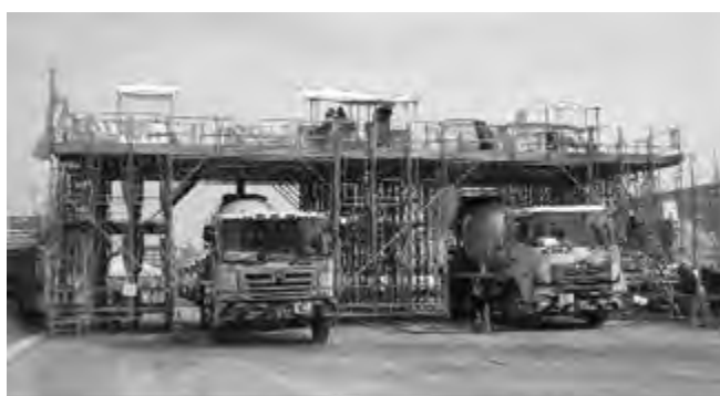
図-19 粒度調整灰添加状況
