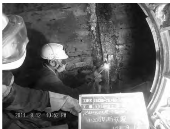
H鋼切断状況
