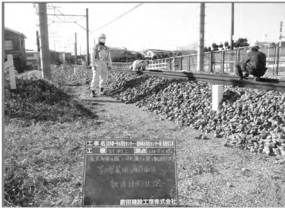
西武多摩川線計測状況
