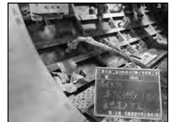
図-22 裏込め注入
