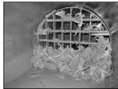
図-9 スクリーン閉塞状況
