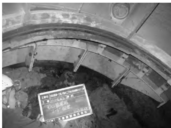
安全フード設置状況
