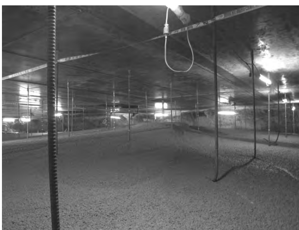
図-18 中埋めコンクリート打設状況
