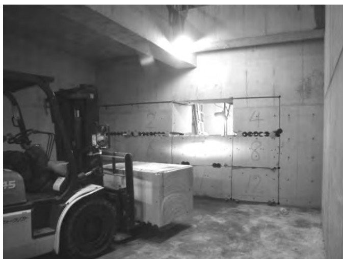
図-20 補強仮壁撤去状況
