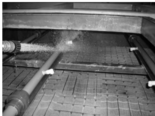
充填材洗浄（清瀬水再生センター）
