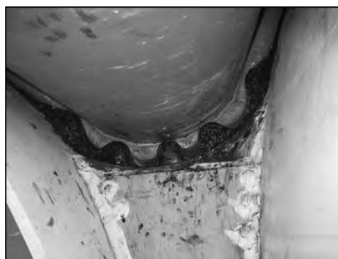
図－8 カモメ部隙間弾性シール充填
