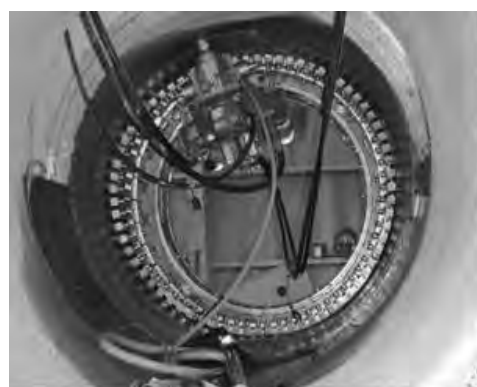
図11 ガイド、切削機設置状況
