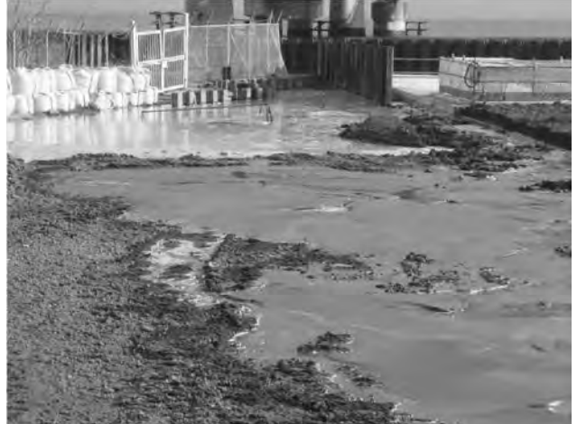
図7. 液状化発生状況
