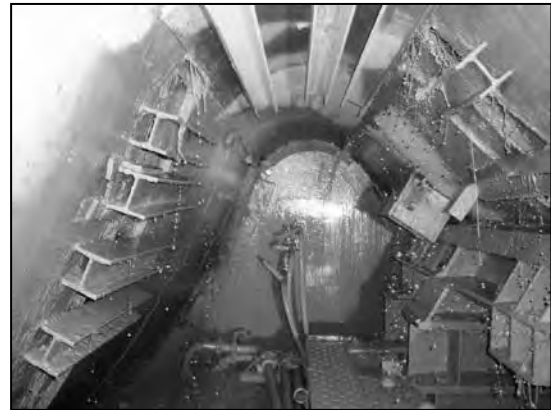
図－16 漏水状況
