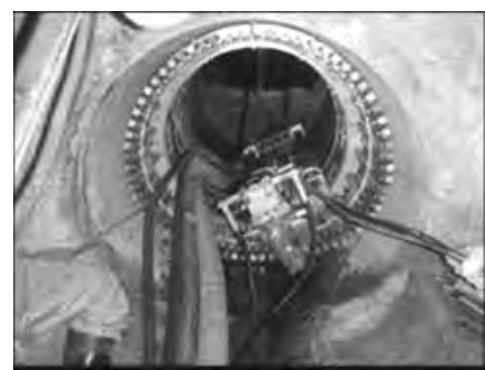
図 21 切削機の設置
