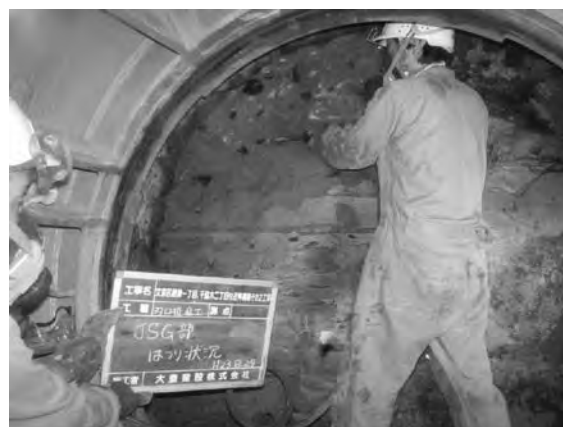
人力掘削状況
