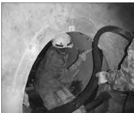
図 25 クッション材 設置状況
