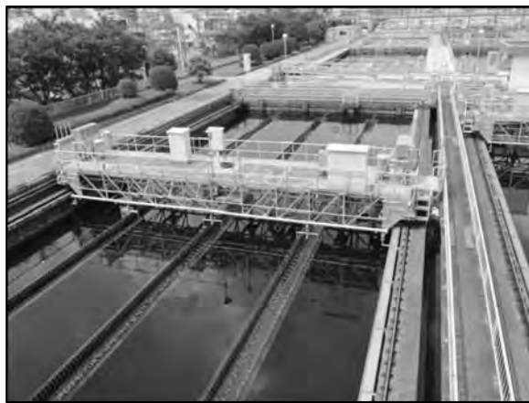
図－2 走行型サイフォン式揚泥方式
