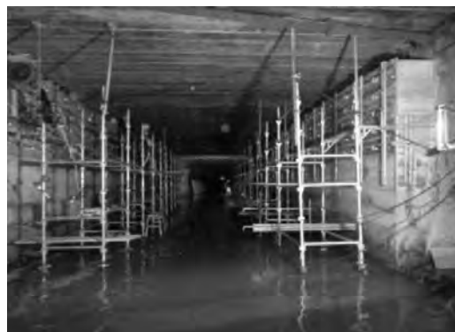
写真－9 内壁コンクリート打設状況
