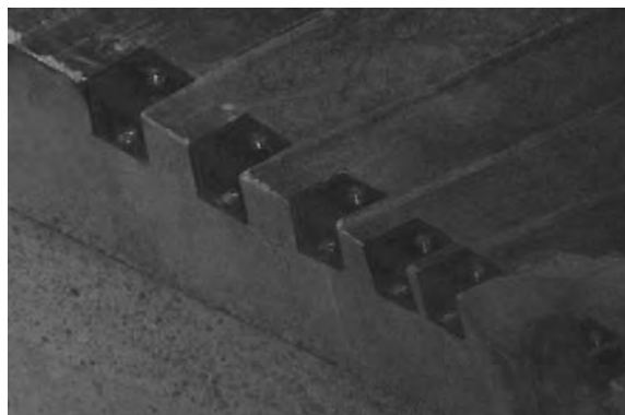
写真-11 頂版浮上防止工施工状況
