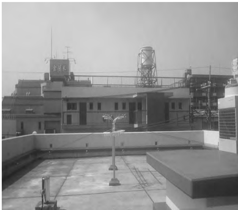
図-1 練馬出張所の施工前の屋上の状況(北から南に向かって撮影)
