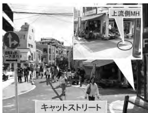
写真－４ 施工箇所状況（上流側）
