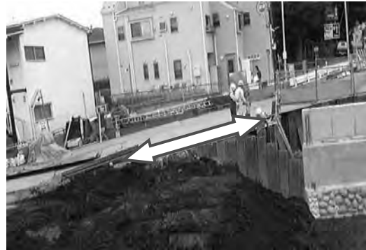
写真－２ 河道内への資機材搬入通路
