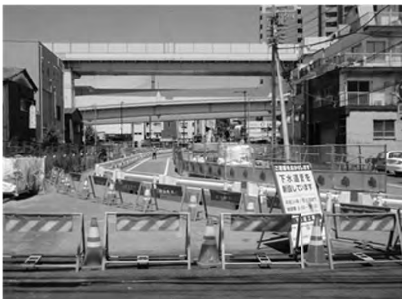
写真４－２：現道切回し後の道路状況
