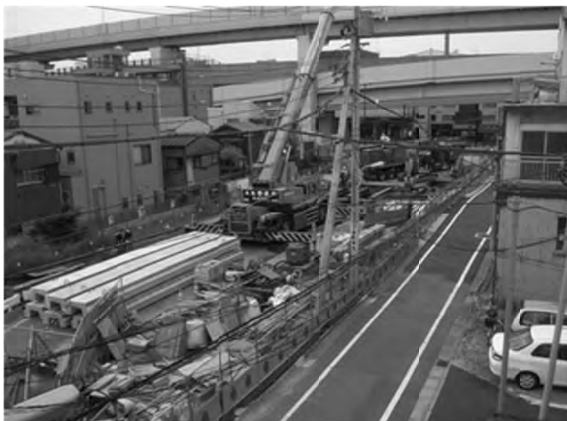
写真4－4：P C版設置状況(全景)
