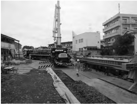
写真－１ 河道内での仮設施工状況
