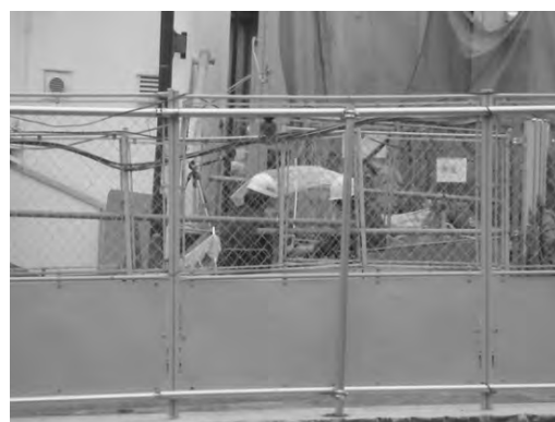
写真－９ 発動発電機の設置場所選定
