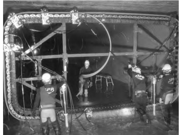
写真－1 製管状況
