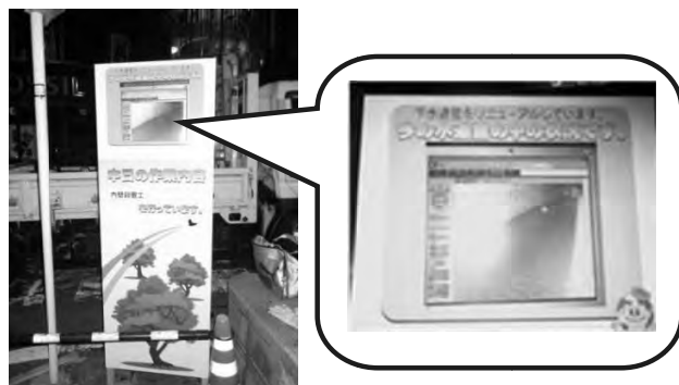
写真-13 管渠内作業状況放映
