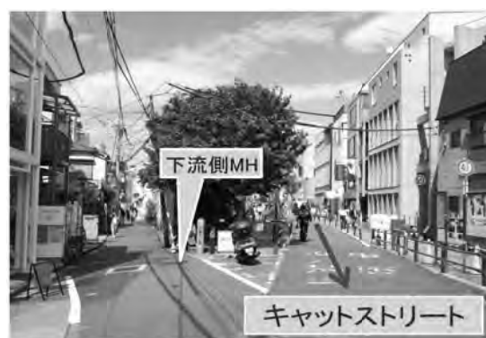
写真－５ 施工箇所状況（下流側）
