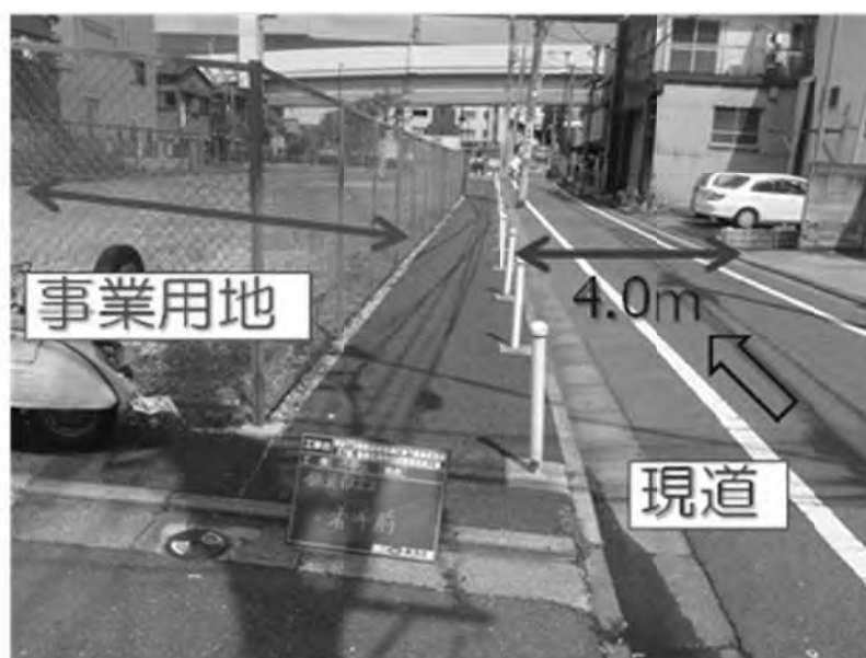
写真 4-1 : 施工前道路状況
