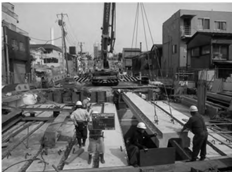
写真4－5：P C版設置状況
