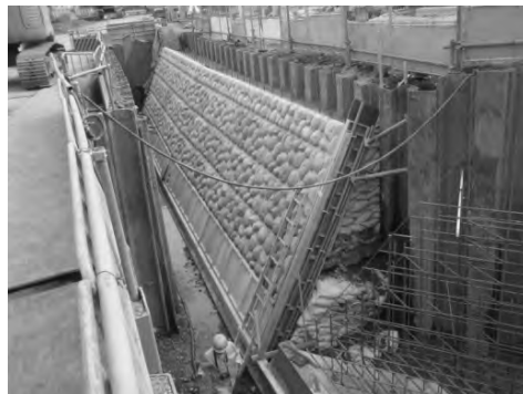
写真－３ 護岸施工状況
