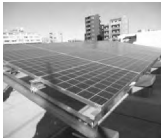
太陽電池アレイ取付後
