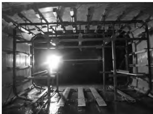
写真-7 仮受支保工設置状況
