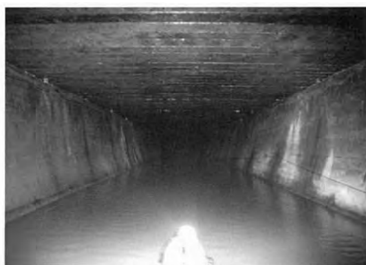
写真－２ 暗渠後の渋谷川
