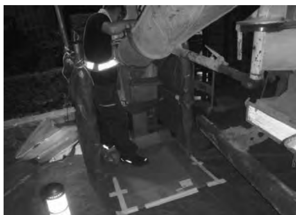
写真－10 雨水桝からの打設状況
