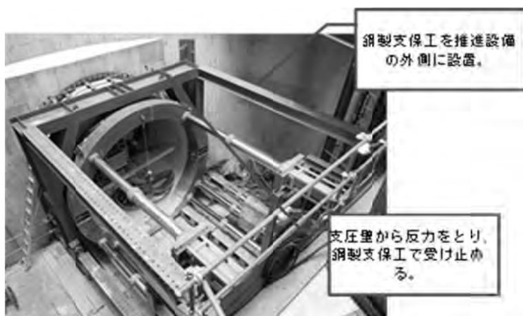
図 6．立坑内、鋼製支保工
