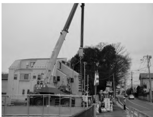
写真－８ 土留め施工状況
