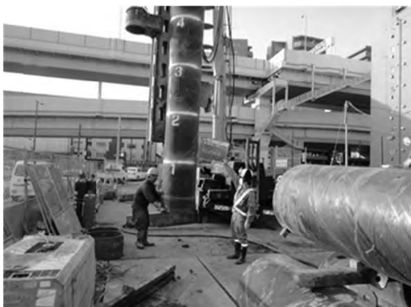
写真４－３：鋼管杭打設状況
