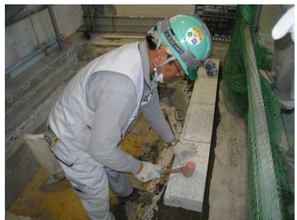
写真 20 開口部の縁石設置状況 (平成 25 年撮影)
