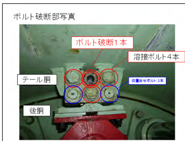
図 4 ボルト破断部写真
