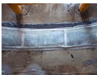
目地部 足掛直下（施工直後）
