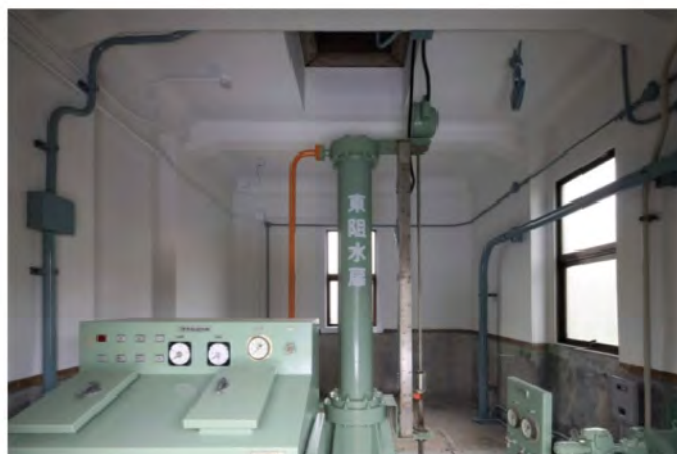
写真10 工事完了の止水扉室 (平成25年撮影)
