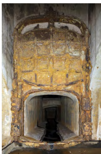
写真 26 工事前の阻水扉 (平成 22 年撮影)
