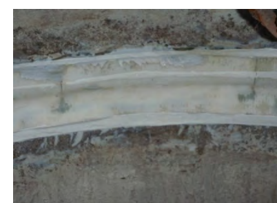
目地部 斜-直（施工直後）
