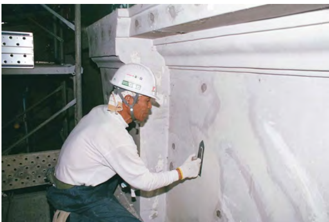
写真 19 漆喰塗の施工状況 (平成 25 年撮影)
