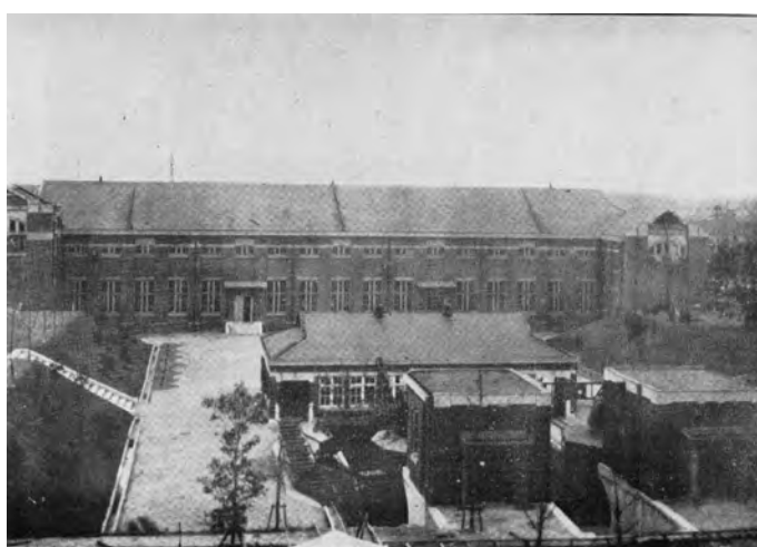
写真 6 建設当時の唧筒場全景 （大正 14 年撮影）
