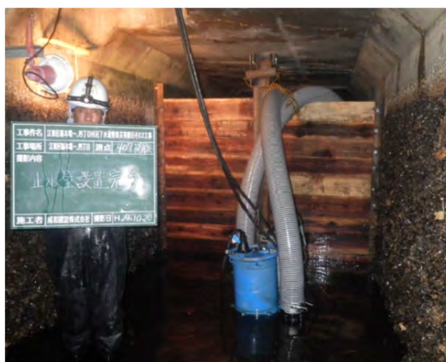
図 15 止水壁の写真
