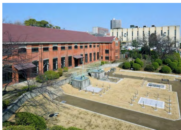
写真2 ポンプ室（平成25年撮影）
