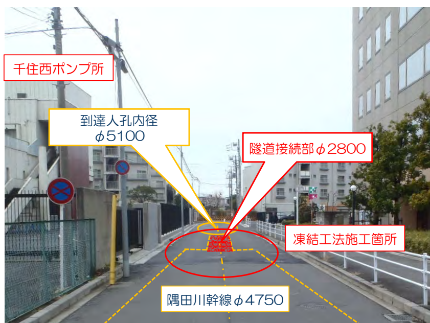
写真1 凍結工法施工箇所
