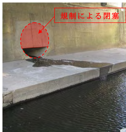
図 2 放流量規制の状況
