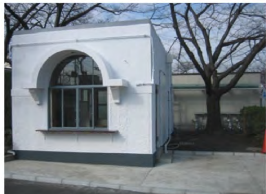
写真8 工事完了後の門衛所
