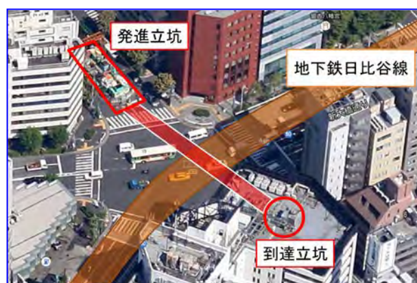
写真 1 地下鉄横断部の直上状況
