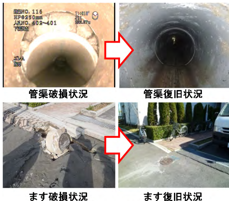
図 16 下水道施設の復旧写真
