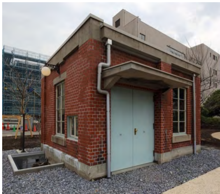
写真 15 工事完了後の土運車引揚装置用電動機室（平成 25 年撮影）
