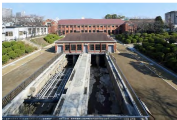
写真12 工事完了後の沈砂池 (平成25年撮影)
