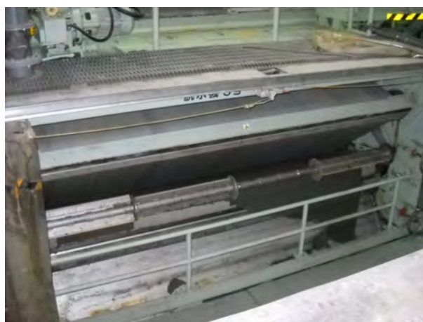
写真 1.4 ベルトプレス型脱水機
