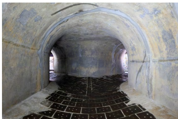
写真 24 工事完了後の接続暗渠 (平成 25 年撮影)
