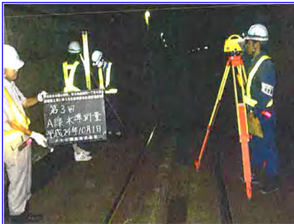
写真 3 水準測量状況
