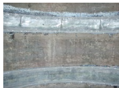
目地部 詳細（施工直後）
