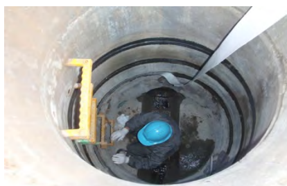
⑤ シート貼付状況
