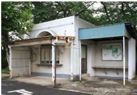
写真7 工事前の門衛所
