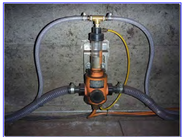
写真 2 沈下計
