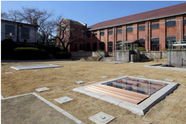
写真 17 工事完了後の量水器室上部 (平成 25 年撮影)
