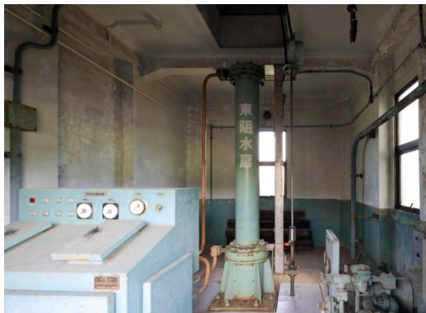
写真9 工事前の止水扉室 (平成22年撮影)
