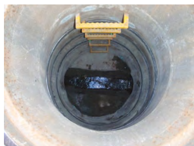
全景（施工直後）
