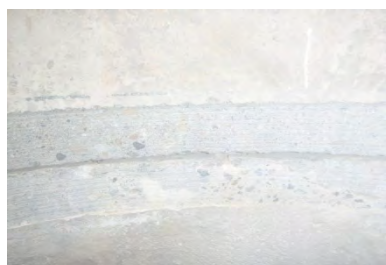
② 目地部切削完了
