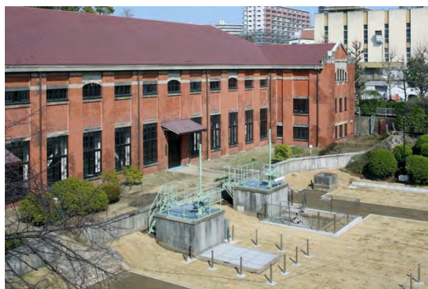
写真 25 工事完了後の中間阻水扉室 (平成 25 年撮影)
