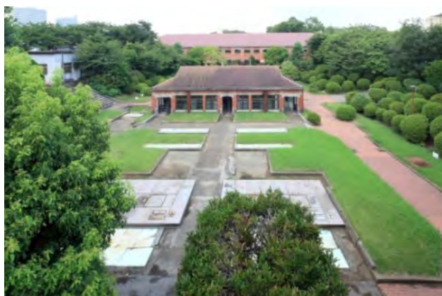
写真11 工事前の沈砂池 (平成22年撮影)
