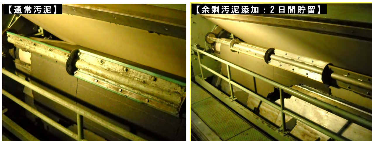
写真 4.1 2日間貯留余剰汚泥を活用した脱水状況
