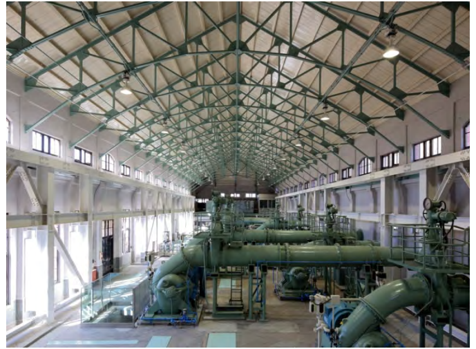
写真 22 工事完了後のポンプ室内部 (平成 25 年撮影)
