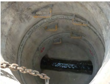
全景（施工直後）
