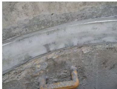
目地部 足掛直上（施工直後）
