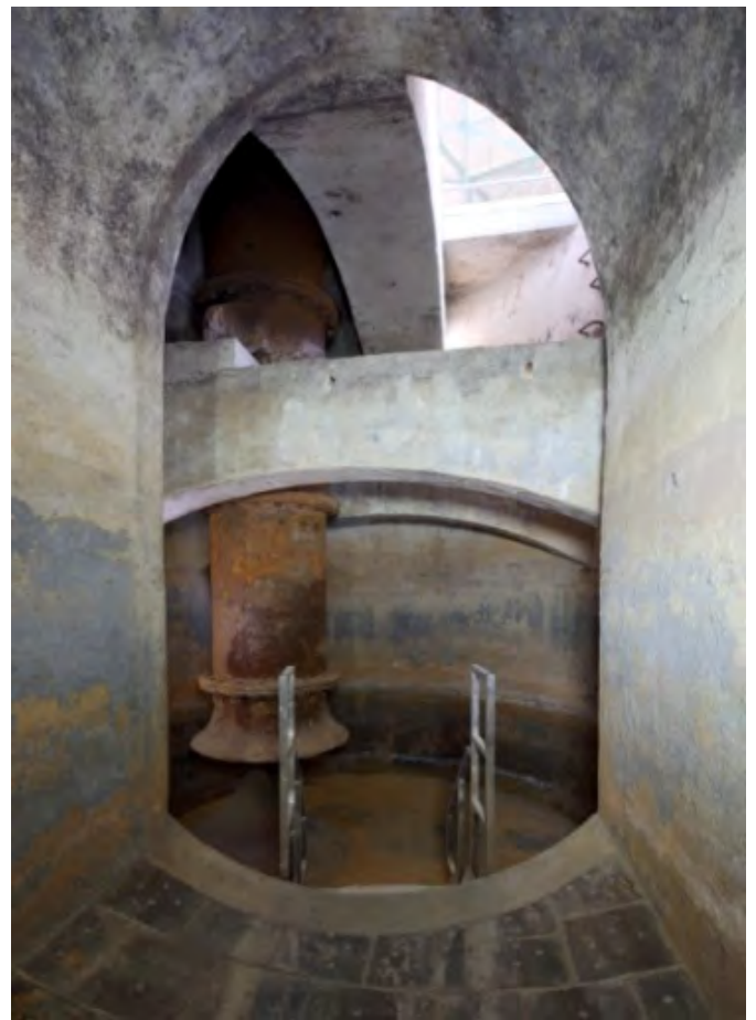
写真 23 工事完了後の唧筒井 (平成 25 年撮影)
