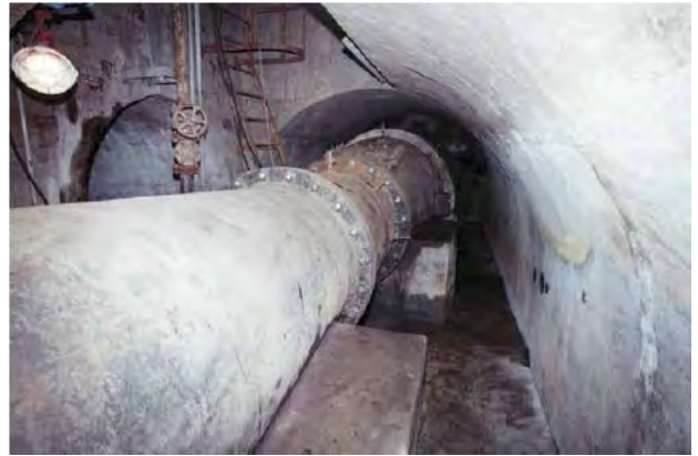
写真 18 露出したヴェンチュリー管 (平成 25 年撮影)
