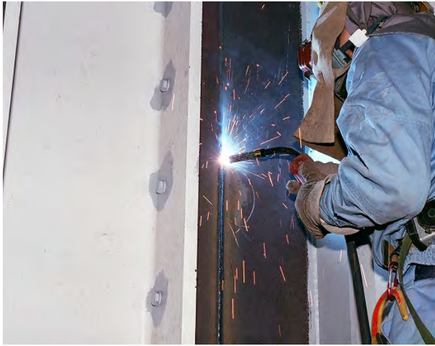
写真 21 耐震補強鉄骨溶接状況 (平成 24 年撮影)
