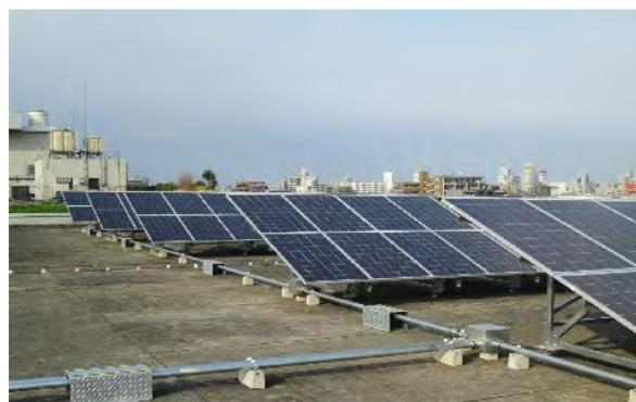
写真-3 太陽光発電設備 50kW
