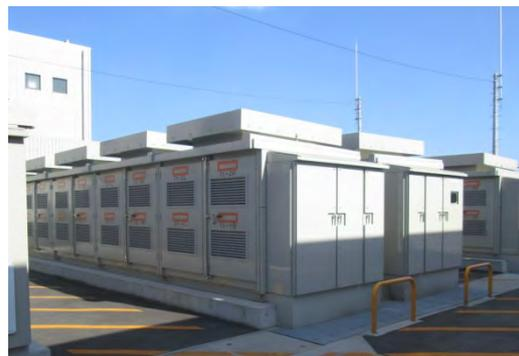
写真-1 NaS 電池設備外形
