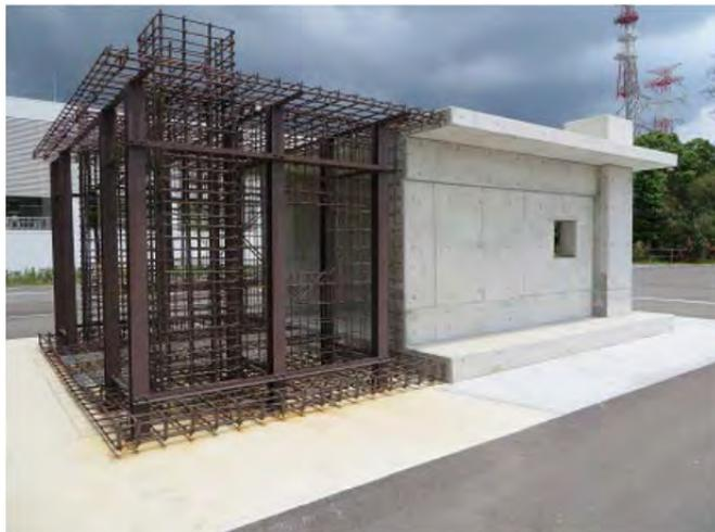
図 12 コンクリート現場打設モデル
