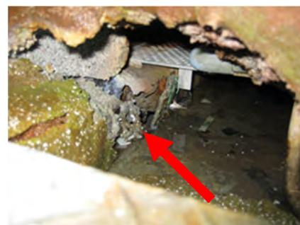
写真 1 排水溝のクラック
