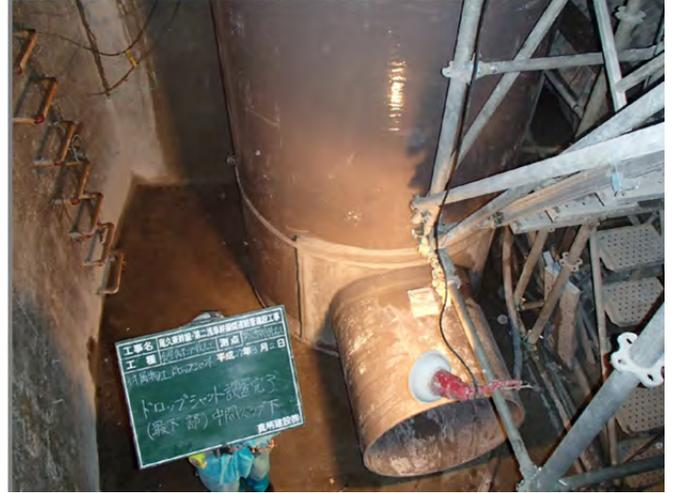
図 18 ドロップシャフト設置完了
