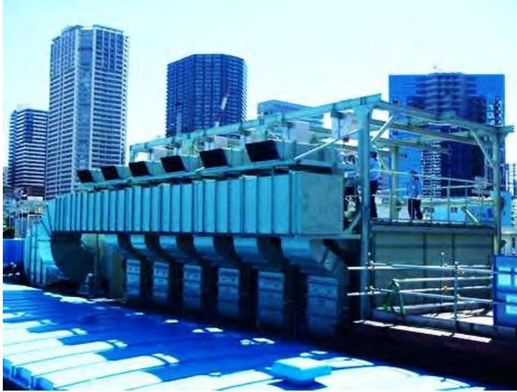
図 1 芝浦水再生センターの脱臭設備
