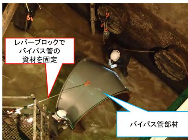
図 10 バイパス管設置状況写真
