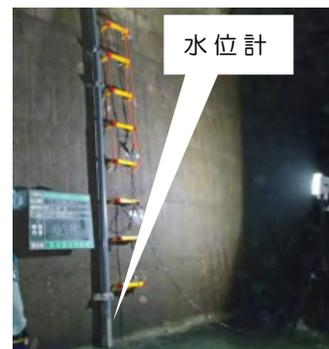
写真-2 水位計設置状況
