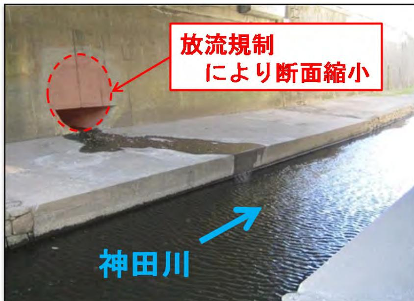
図-1 放流規制により断面縮小された吐口
