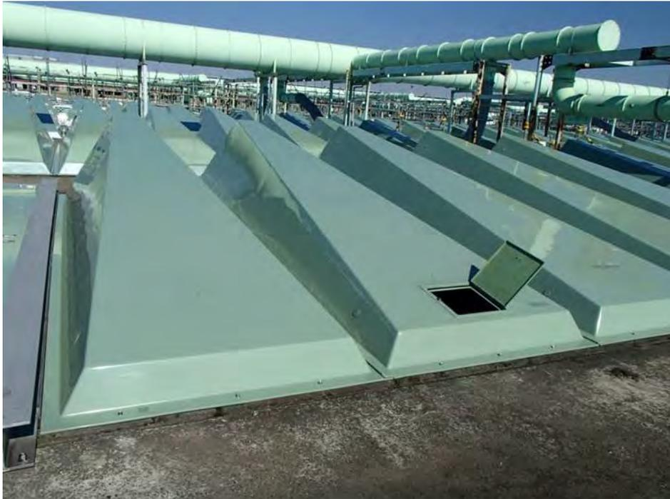
図3 架台機能付覆蓋設置状況
