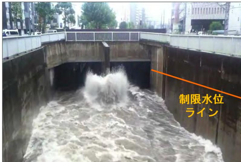
図-4 大雨時の様子（吐口設置箇所付近）
