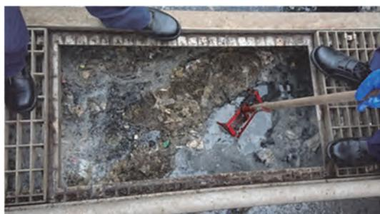
図2 第一沈殿池のふさ（砂系）
