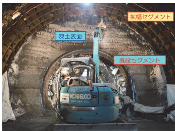
図6 凍土掘削状況
