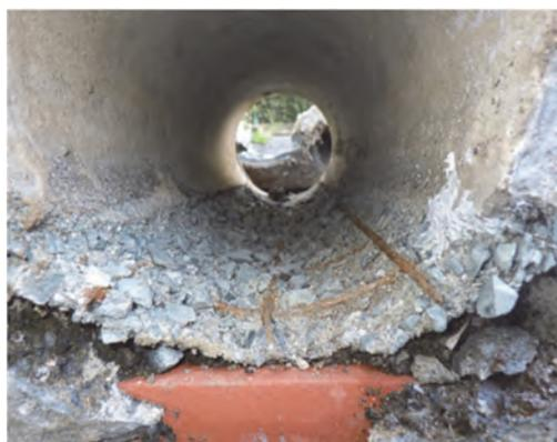
図 2 取付管損傷状況
