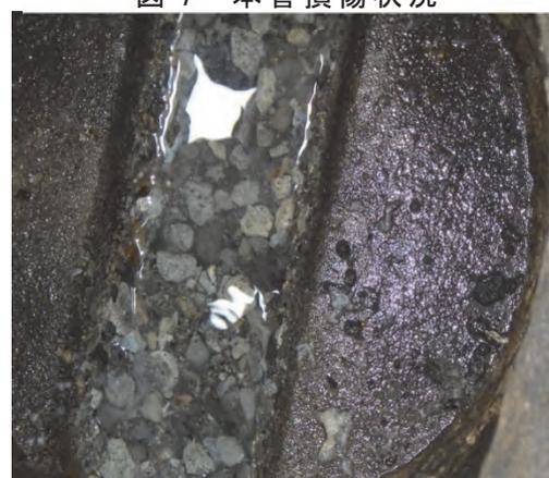
図 8 インバート部損傷状況
