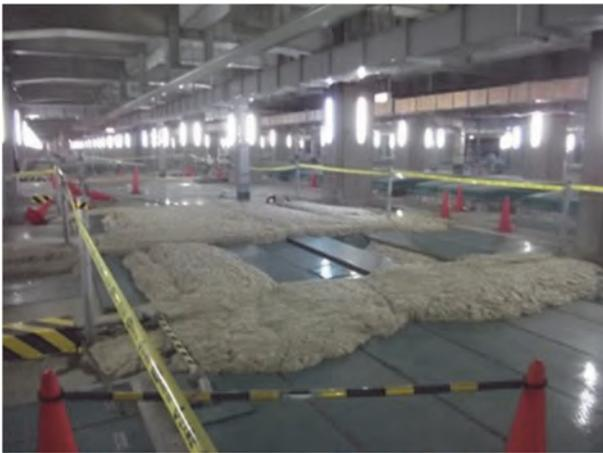
図 1 深槽東系反応槽の異常発泡状況（2017 年度）
