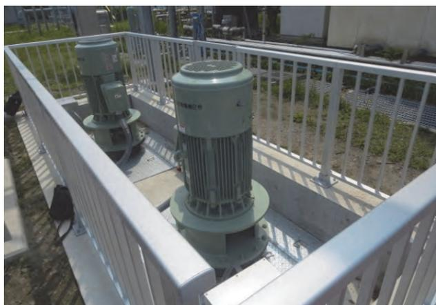
図5 増設小水力発電機（電動機）
