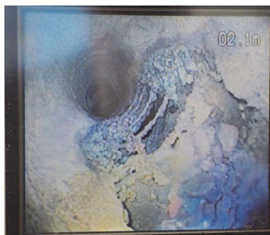
図 9 取付管の損傷状況
