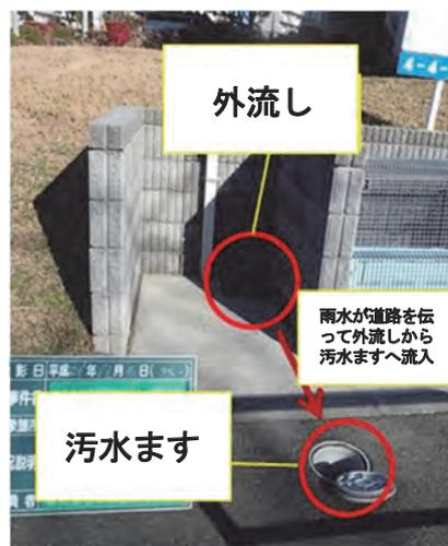
図 12 ごみ集積所（外流し）の構造
