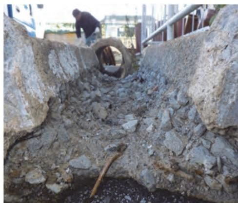
図 1 公共ます(底塊) 損傷状況
