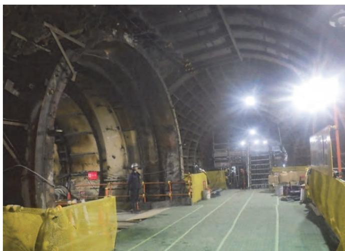
図7 シールド到達後接続部写真
