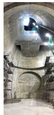
発進立坑内部
