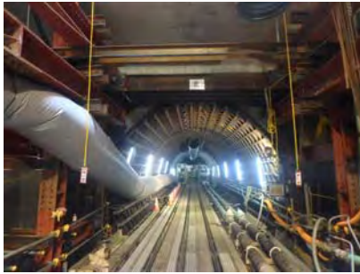
隅田川幹線のシールドトンネル坑口部
