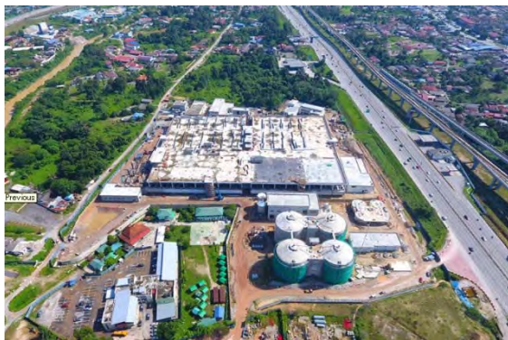
ランガット下水処理場（平成30年7月） （出典：LANGAT SEWERAGE PROJECT HP）
