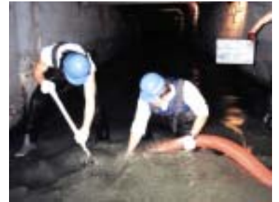
人力による管きよ内の清掃
