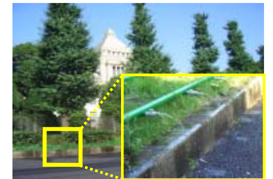
保水性舗装への散水(永田町及び霞が関地区。現在は地下鉄駅の湧水を使用しているが、再生水に変更予定)
