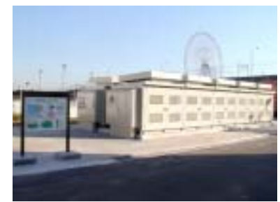
電力コストを縮減するNaS電池
