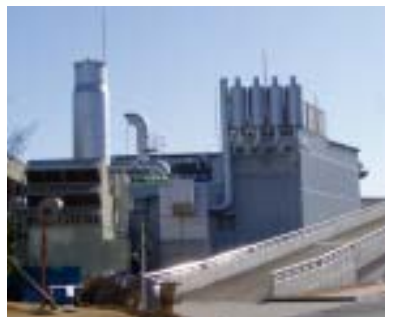
下水汚泥から発生するメタンガスを利用したバイオマス発電
