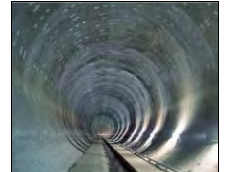
雨水を貯留する下水道管(和田弥生幹線)
