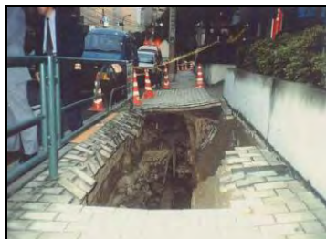
老朽化した下水道管が原因で陥没した道路
