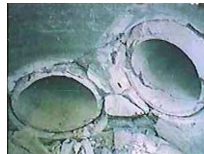
下水道管とマンホールの接続部の破損
