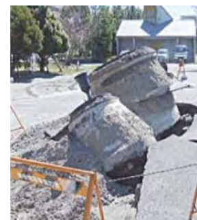
液状化現象により浮上したマンホール
