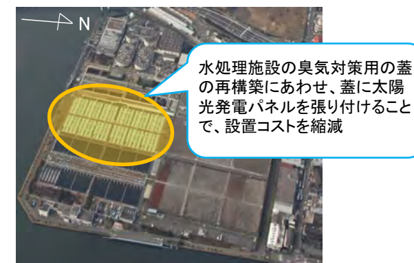
森ヶ崎水再生センターでのメガワット級太陽光発電の導入
