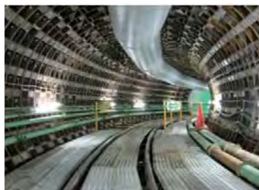
＜施工中の第二立会川幹線＞
