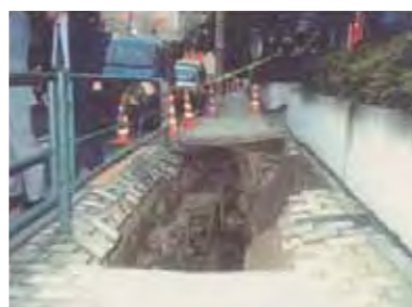
<陥没した歩道>
