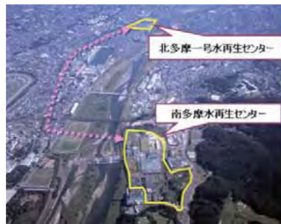
<連絡管で結ばれる2つの水再生センター(北多摩一号~南多摩水再生センター間)>
