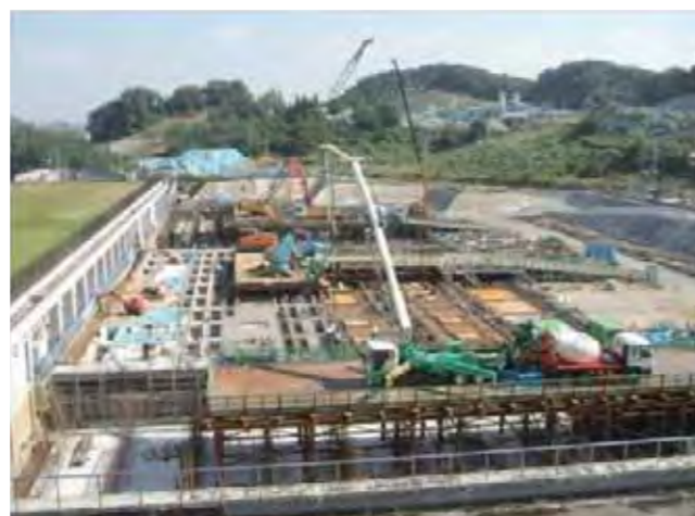
＜高度処理施設の建設(南多摩水再生センター)＞
