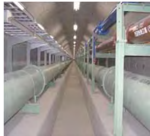
<連絡管の内部>
