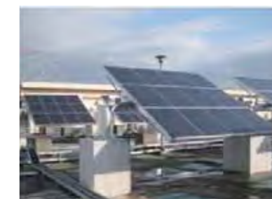
太陽の方位にあわせて発電パネルが動く「一軸追尾方式太陽光発電」を開発
