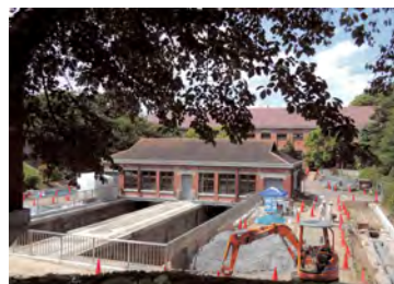
旧三河島污水処分場唧筒（ポンプ）場施設の復原・保存工事
