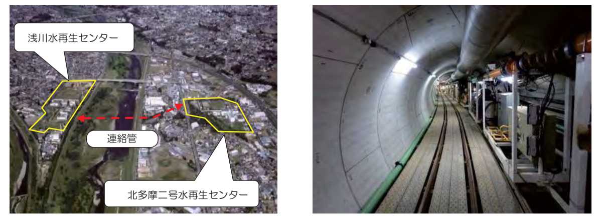
▶ 北多摩二号・浅川水再生センター間の連絡管は、平成28年度の稼働を目標に整備を進めています。
