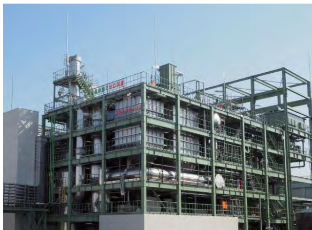
▶ 新たな燃焼方式の汚泥焼却炉で、従来の焼却炉と比べて排出される温室効果ガスを約50%削減できます。
