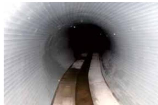
▶ 勝島運河流域貯留管の整備により、降雨初期の汚れた下水が収容され、勝島運河の水質が改善されます。(貯留量4,900m<sup>3</sup>)
