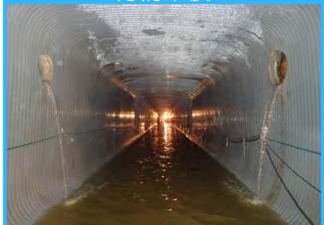
▶ コンクリート表面の劣化などにより強度が低下した下水管の内面に、硬質塩化ビニル材などを巻いて補強します。
