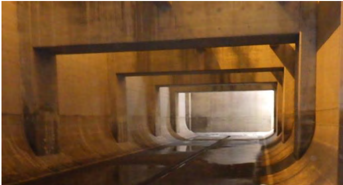
＜森ヶ崎水再生センター雨天時貯留池＞
