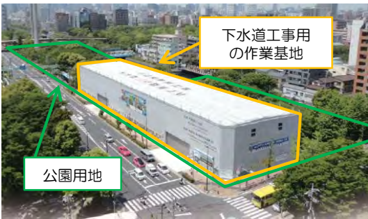
公園用地にある作業基地
