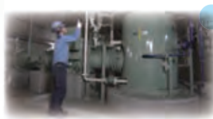
ポンプ設備の点検
