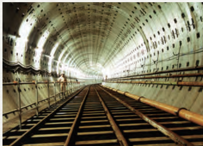
▲シールド工法による地下鉄並みの下水道幹線
