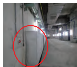
壁の厚みを増して耐震補強が完了した状況
