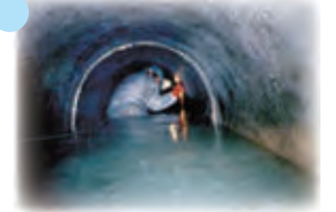
人力による下水道管内の調査
