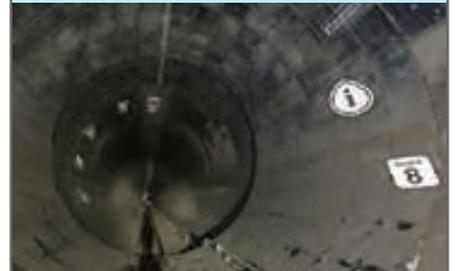
大雨の一部を一時的に貯留する、浸水対策の下水道管です。雨水を 150,000m<sup>3</sup>（小学校プール約 500 杯分）貯めることができます。地下 50 メートル、内径 8.5m の巨大な下水道管をご案内します。
