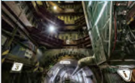
1時間 50 ミリの降雨に対応する、浸水対策の下水道管です。シールド工法と呼ばれるトンネルを掘り進む工法で、内径 3.5m の下水道管を建設する工事現場をご案内します。
