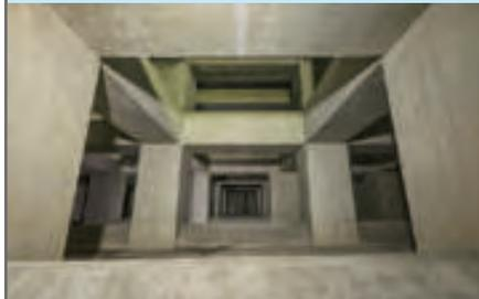
大雨の一部を一時的に貯留する、浸水対策の施設です。雨水を 25,000m<sup>3</sup>（小学校プール約 80 杯分）貯めることができます。巨大なポンプ設備や、大きな柱が林立する地下空間をご案内します。
