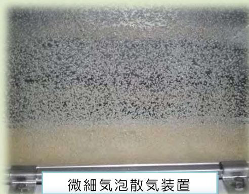
微細気泡散気装置
