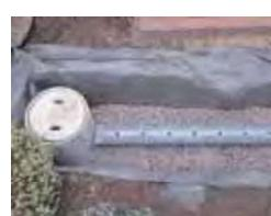
雨水浸透施設は、がけ地のように雨水を浸透させると地盤が緩んで危険な場所や、地下水の浸透しにくい場所を除いて、広く普及させることでその効果を発揮します。
