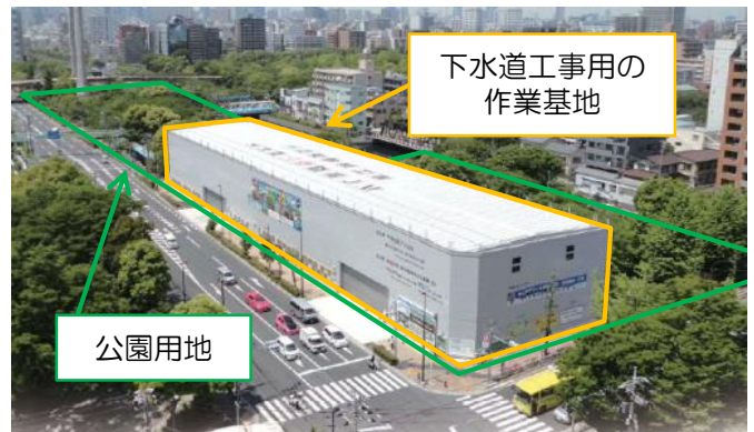
公園用地にある作業基地
