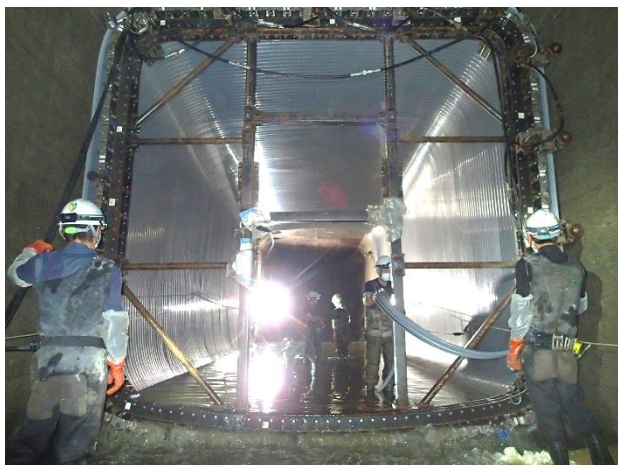
下水を流したまま管路内を施工の様子
