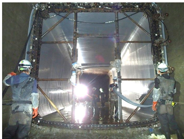
下水を流したまま管路内を施工する様子
