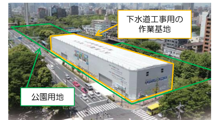
公園用地にある作業基地
