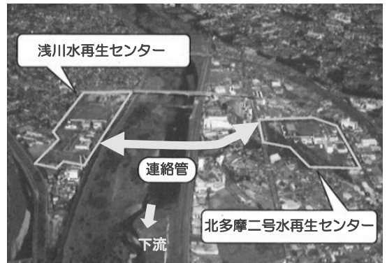
▲北多摩二号・浅川水再生センター間連絡管 (平成27年度完成)
