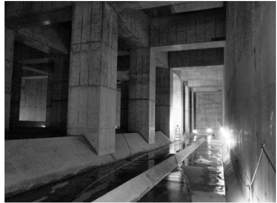
図表4-17 野川下流部雨水貯留池
