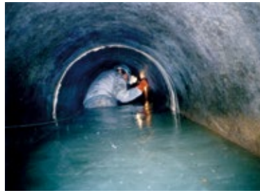
人力による下水道管内の調査
