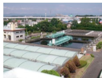
立川市・錦町下水処理場
