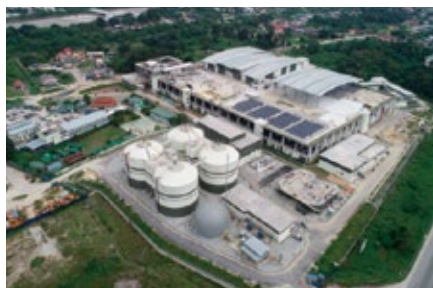
東京下水道の技術が活用されている マレーシアの下水処理場建設現場
