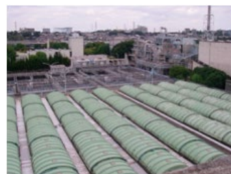
八王子市・北野下水処理場
