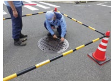
人孔蓋の点検
