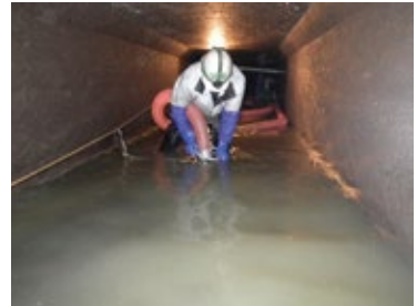
人力による下水道管内の清掃
