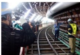
第二田柄川幹線その2 工事現場
