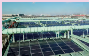
水処理施設の臭気対策用の蓋に、1,000kW (メガワット級)の太陽光パネルを設置
