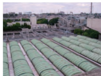
八王子市・北野下水処理場
