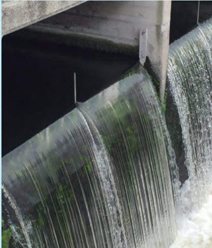
きれいに処理された水
