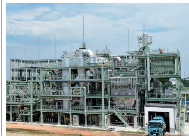
南多摩水再生センター汚泥ガス化炉
