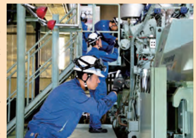
TGS社員による下水道施設の点検作業
