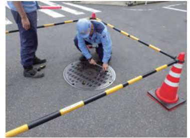
マンホール蓋の点検
