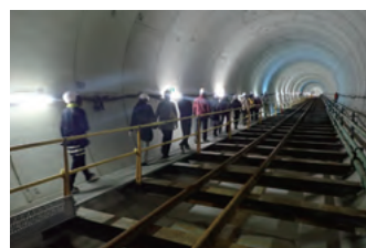
江東幹線工事現場
