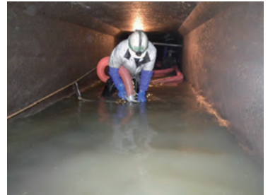
人力による下水道管内の清掃
