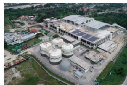
東京下水道の技術が活用されているマレーシアの下水処理場建設現場 (出典：LANGAT SEWERAGE PROJECT HP)
