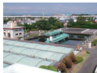
立川市・錦町下水処理場
