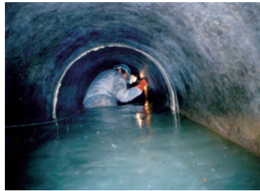
人力による下水道管内の調査
