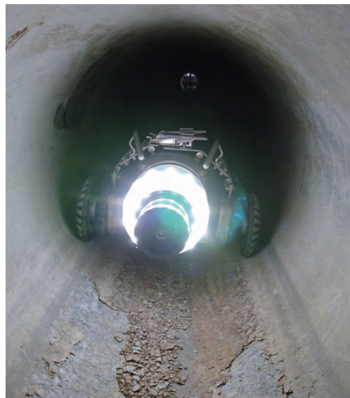
(ミラー方式テレビカメラによる下水道管の調査)
