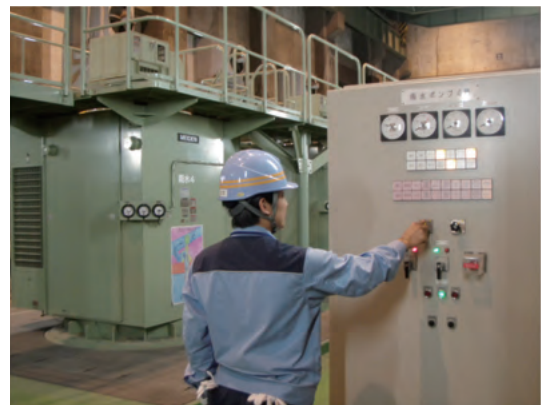
ポンプ設備の点検
