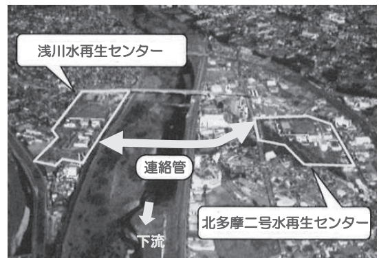
▲北多摩二号・浅川水再生センター間連絡管 (平成27年度完成)
