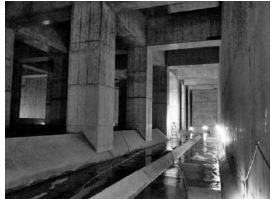
図表4-17 野川下流部雨水貯留池
