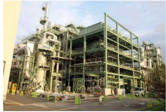
建設中のエネルギー自立型焼却炉
