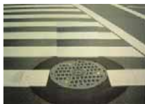
▲浮上・飛散防止型マンホール蓋への取替え状況
