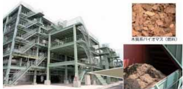
図表4-18 下水汚泥と木質系バイオマスの混合焼却施設（多摩川上流水再生センター）
