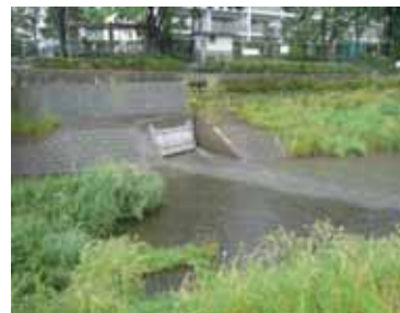
▲雨水吐口からの流出状況
