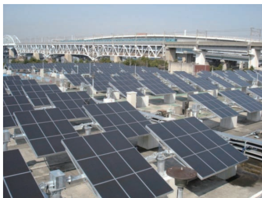
図表 5-6 葛西水再生センター 太陽光発電設備（一軸追尾）
