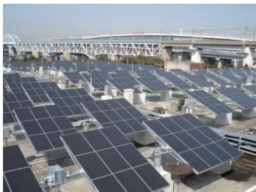
一軸追尾タイプは、太陽光パネルが太陽を追尾するように動くので発電量の増加を図ることができます。また、太陽光パネルが動くので、太陽光パネルの下部に設置されている水処理施設の点検、工事の際に支障がないように運用することができます。
