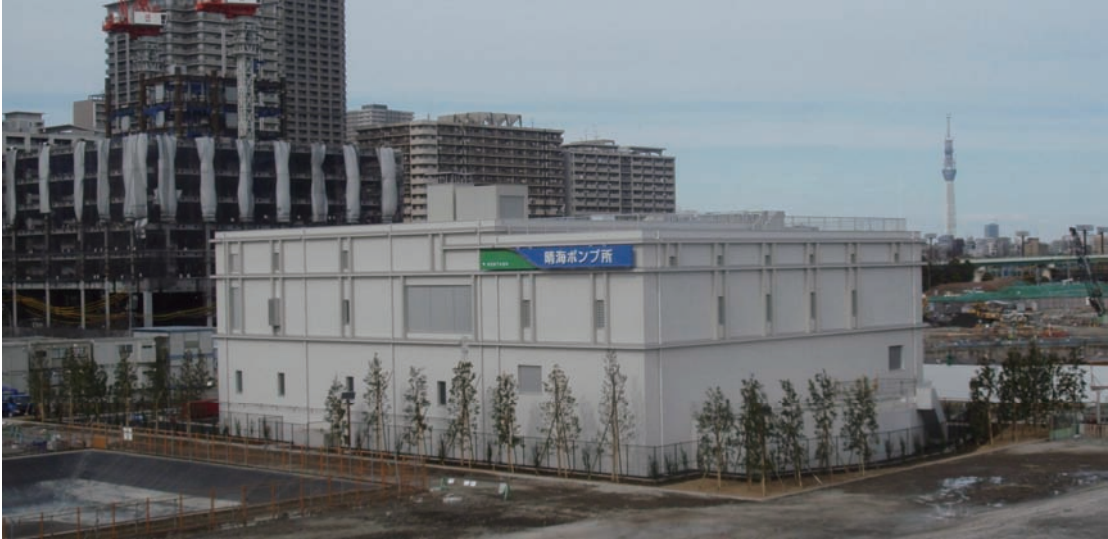
《晴海ポンプ所外観》
