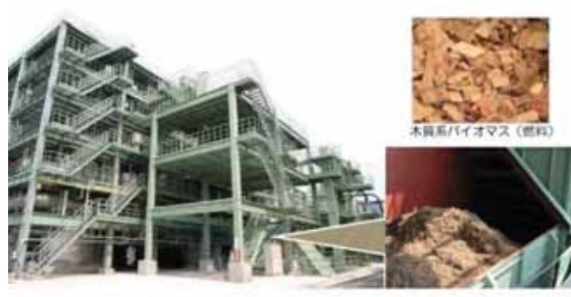
図表4-19 下水汚泥と木質系バイオマスの混合焼却施設 (多摩川上流水再生センター)
