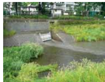
▲雨水吐口からの流出状況
