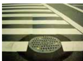
▲浮上・飛散防止型マンホール蓋への取替え状況
