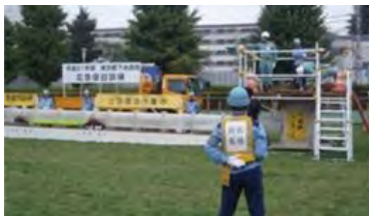
図表6-1 下水道管応急復旧訓練
