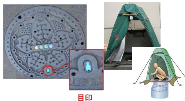
図表6-2 仮設トイレの設置が可能なマンホール及び仮設トイレ
