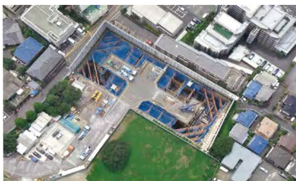
野川下流部雨水貯留池（平成25年度完成予定）
