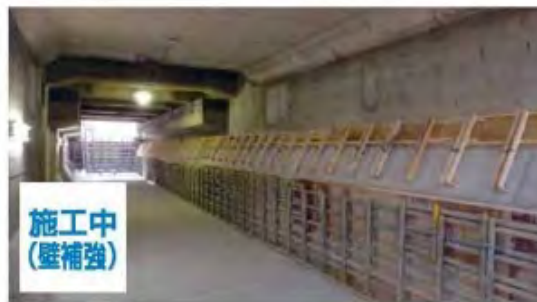
耐震補強例（写真は施工中）
