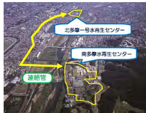
▲北多摩一号・南多摩 水再生センター間連絡管 (平成24年度完成)
