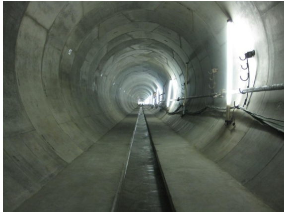
《写真:練馬区中村地区浸水対策施設貯留管内部》
