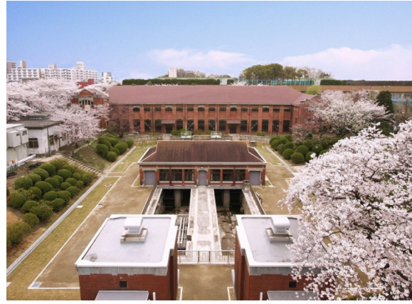
《写真:下水道施設初の重要文化財旧三河島污水処分場唧筒(ポンプ)場施設全景》
